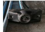
Figura 2. Anclaje Fuente: Propia
