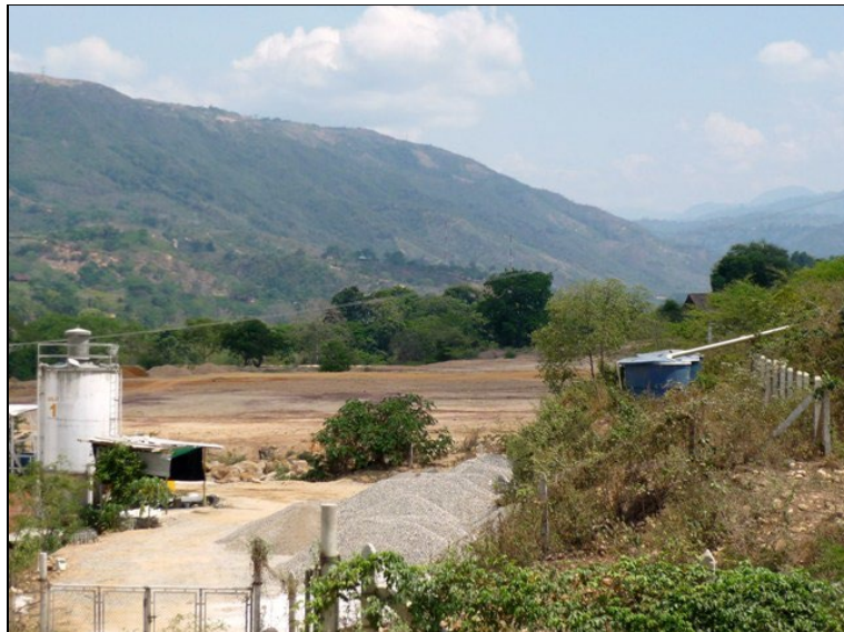
Foto 16 Rellenos compactados, sector industrial Bucaramanga y Girón, margen derecha Río de Oro
