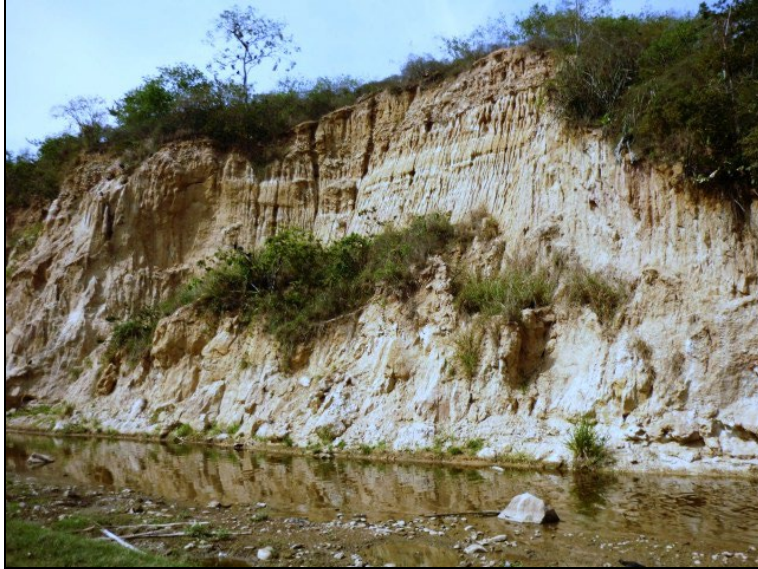
Foto 8 Miembro Órganos afectados por socavación del río de Oro
