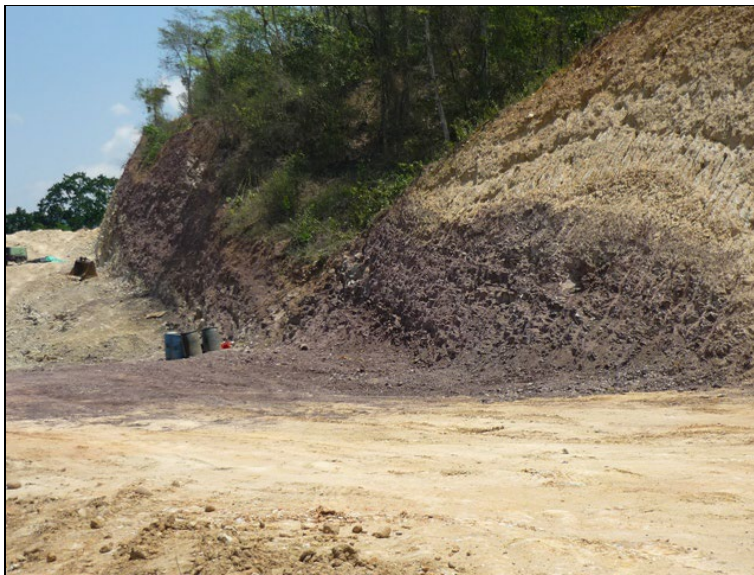
Foto 6 Limolitas de la Formación Girón, taludes de corte ampliación vía Palenque, Café Madrid
