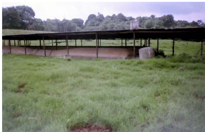
Figura 24. Biodigestores presentes en la granja.
