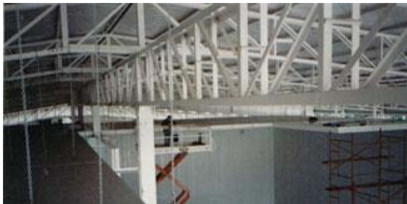
Figura 4. Estructura del Techo de la Cámara
