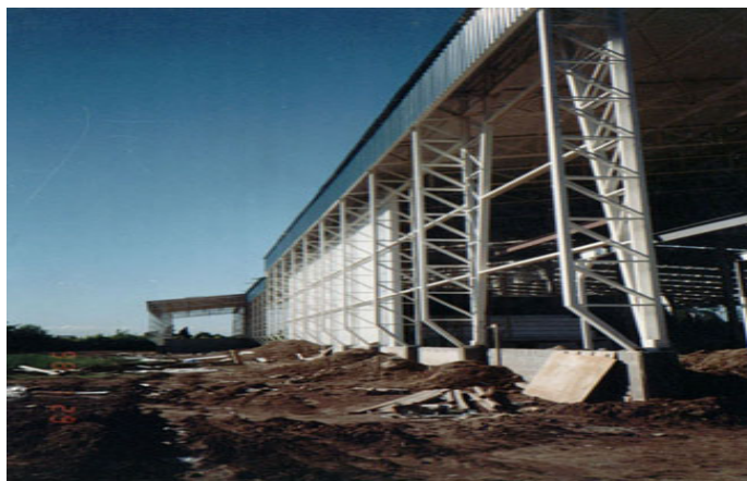
Figura 6. Cerramientos Verticales de la cámara
