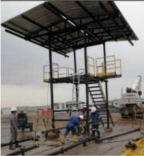
Fotografía 19. Estructura de un cargadero de crudo y agua.
