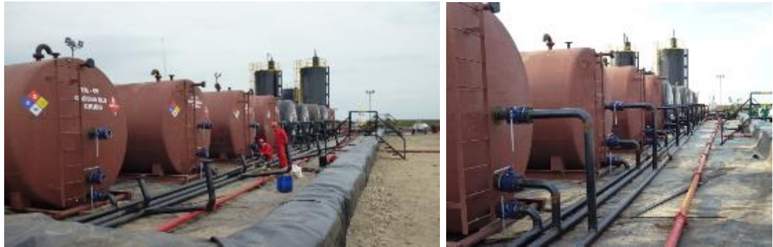
Fotografía 18. Líneas de soldadas prefabricadas antes y después de ser instaladas.
