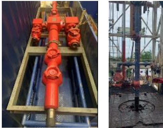
Fotografía 3. Cabezal de prueba.
