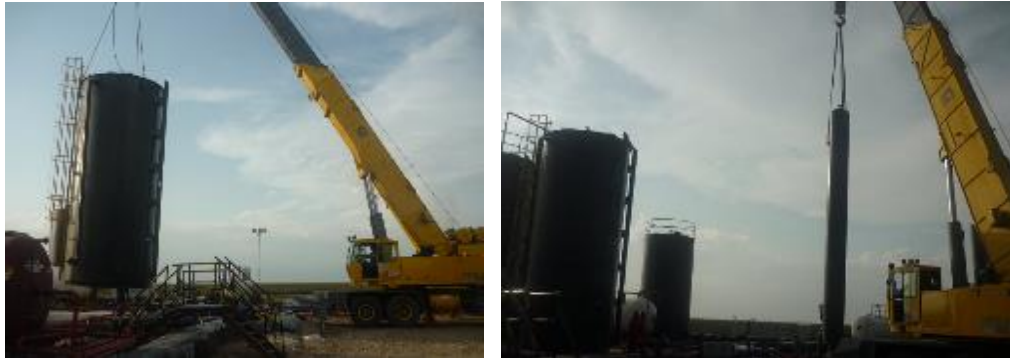
Fotografía 28. Imagen de un izaje y ubicación de un GB de 500 bbl.
