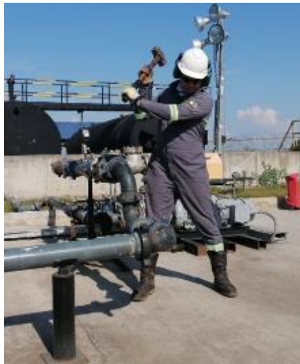
Fotografía 21. Uso de marro o porra para el ajuste de uniones de golpe.
