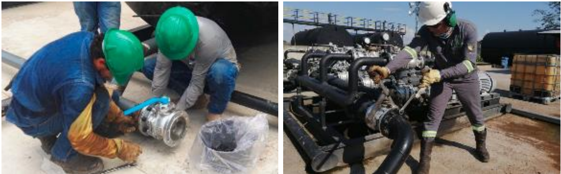
Fotografía 34. Ajuste de una unión bridada.
