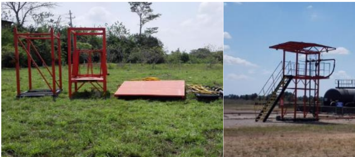
Fotografía 29. Imagen de cargadero de fluidos.
