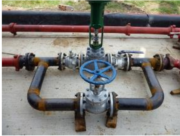
Fotografía 38. Cuadro de control de interfase de un GB, prefabricado.
