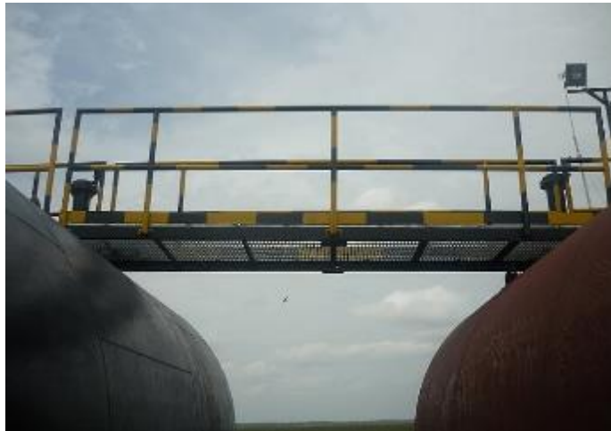
Fotografía 30. Pasarela instalada en tanques de almacenamiento.
