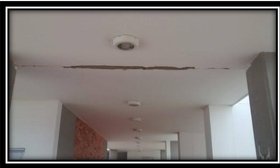
(d). Registros fotográficos de las grietas y caída de parte del techo
