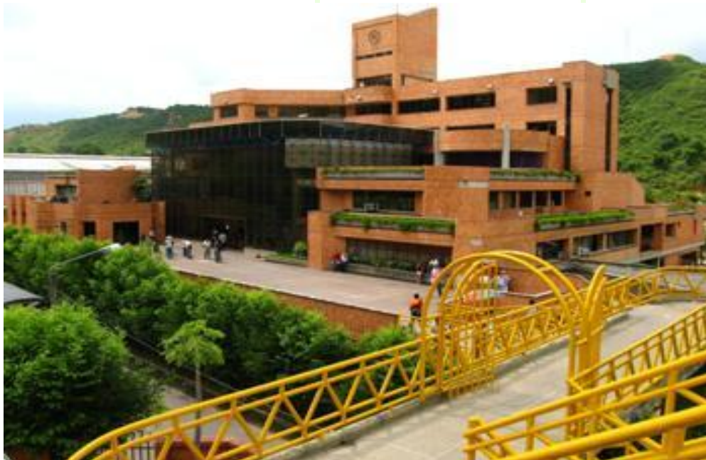
Ilustración 1 Sede principal Dirección de Tránsito de Bucaramanga
