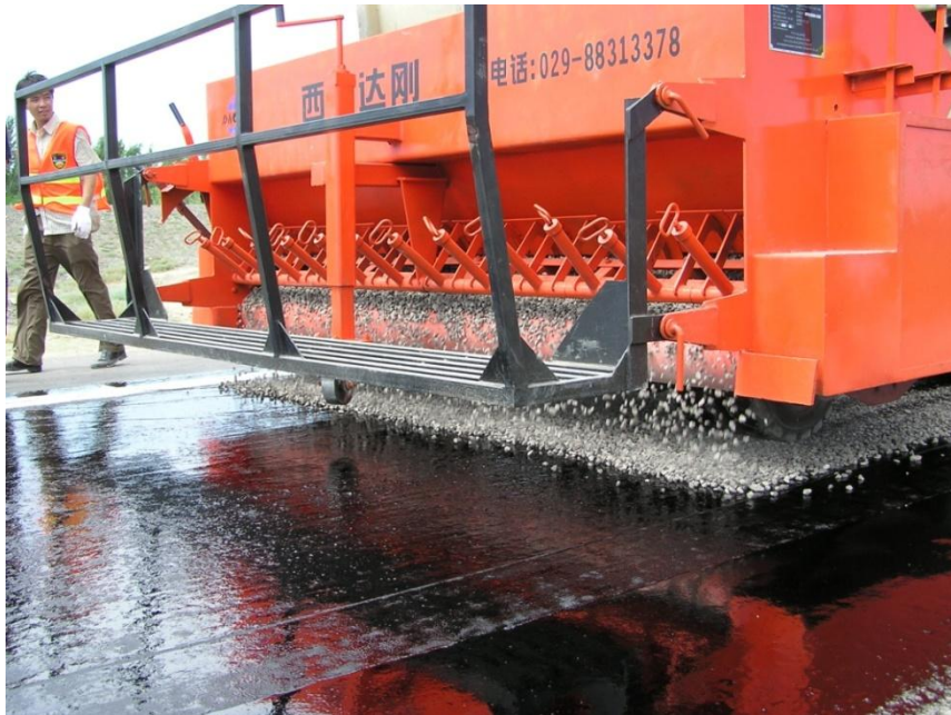
Figura 17. Modelo de maquinaria autopropulsada para la extensión de gravillas
