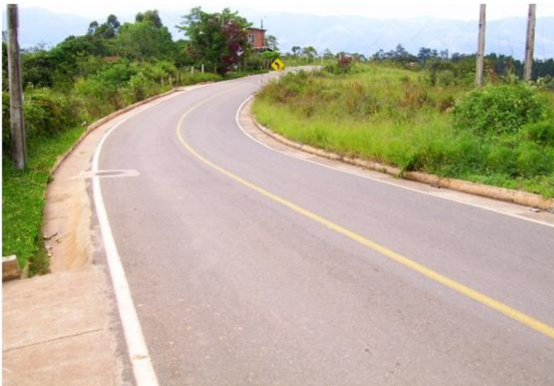
Figura 8. Vía anillo vial: Floridablanca – Ruitoque
