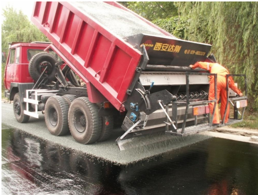
Figura 18. Ejemplo en la Aplicación de Gravillas
