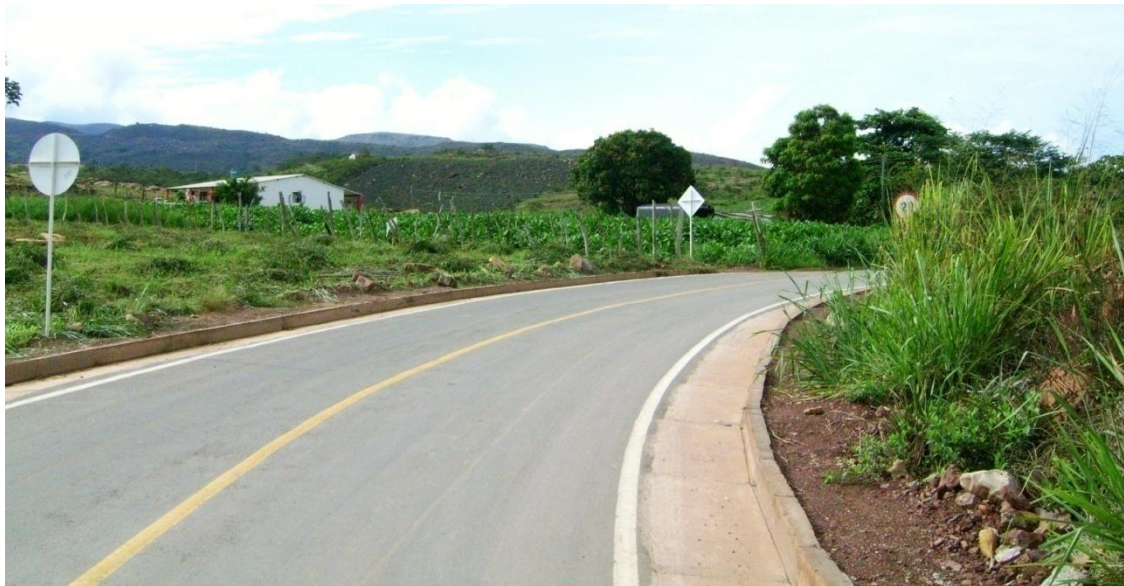
Figura 4. Vía Zapatoca – Girón - Km 32+850 al Km 36+000
