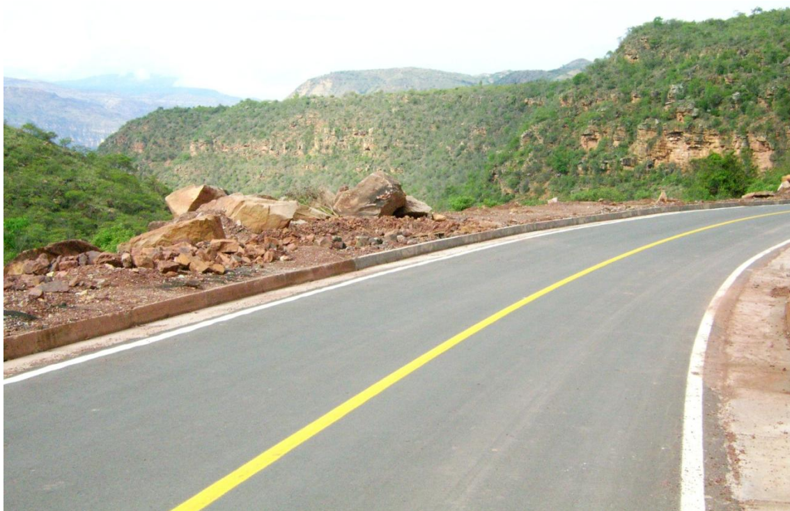
Figura 5. Vía Zapatoca – Girón - Km 28+350 al Km 32+850
