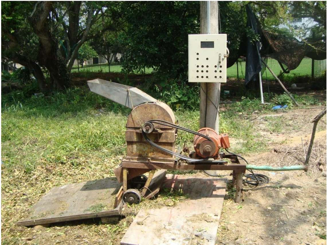
Figura 6. Instalación de molino de martillos con su respectiva acometida eléctrica trifásica, está probado y listo para operar.
