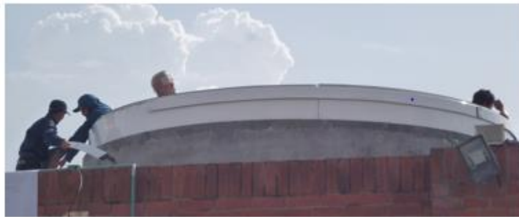
Figura 55. Cinturón sobre la base del domo
