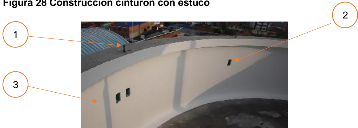
Figura 28 Construcción cinturón con estuco
