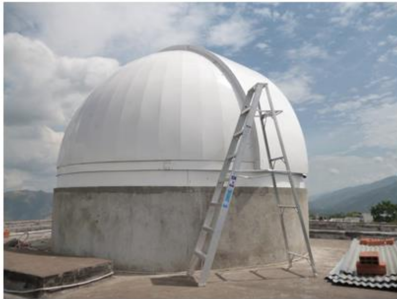
Figura 59. Domo con la compuerta
