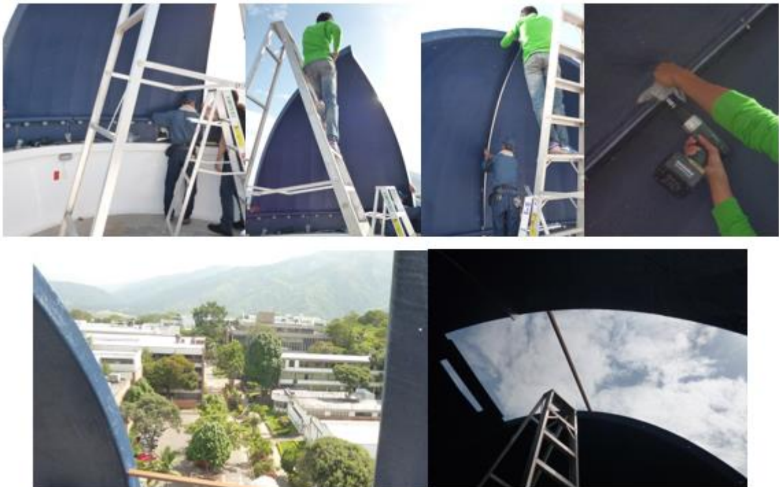
Figura 58. Montaje de los cascarones del domo
