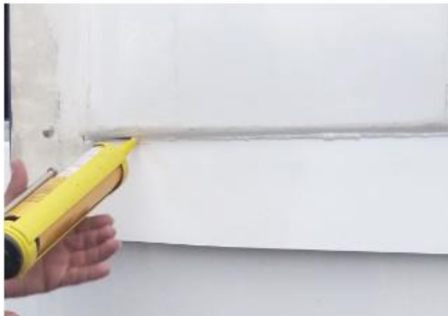
Figura 60. Sellado con silicona
