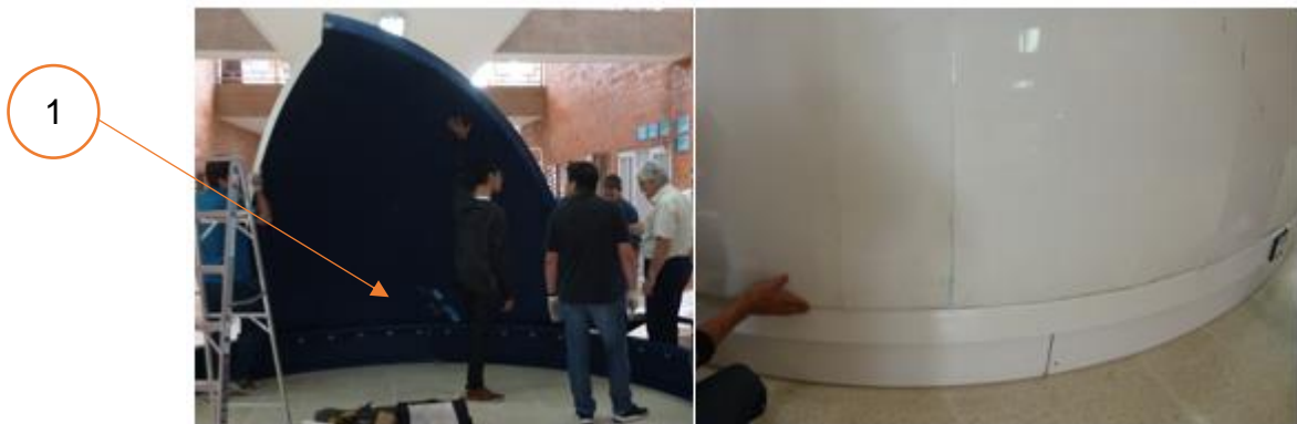
Figura 46. Montaje Cascarones sobre el cinturón
