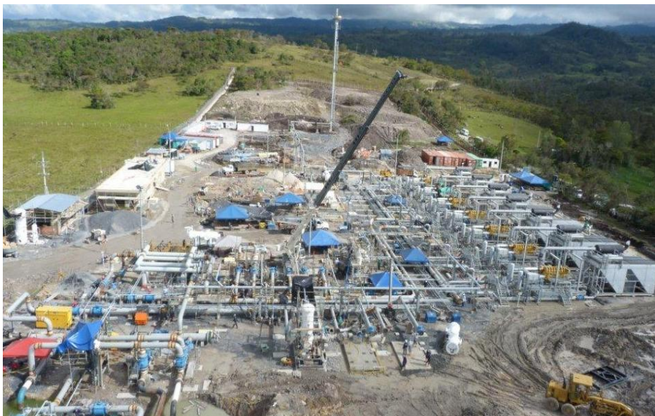
Imagen 2. Estación compresora tecnología reciprocante
