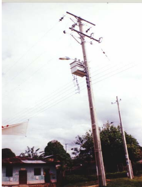
Fotografía 4. Redes de media y baja tensión del Corregimiento La Pedrera.
