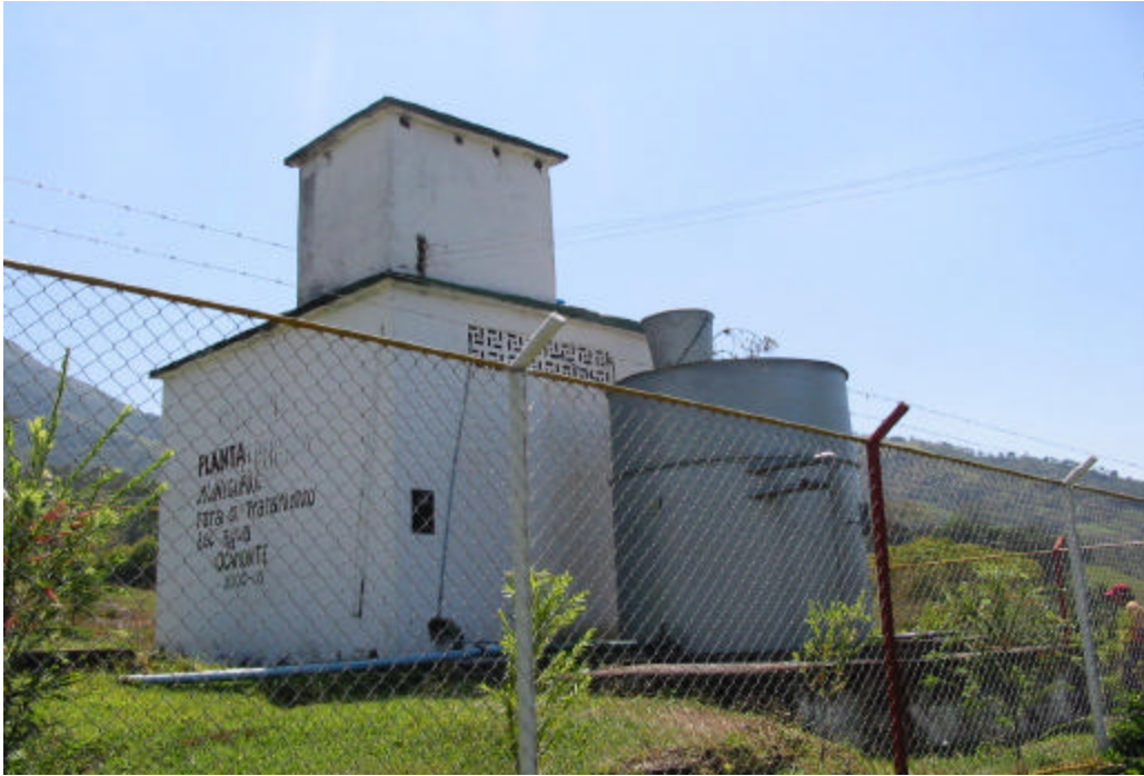
Planta de tratamiento de agua. Quebrada la Arenera
