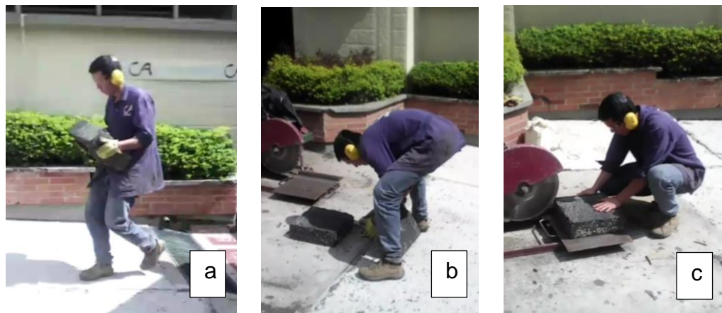
Figura 8. Postura del operario durante el uso del equipo. (a) Transporte de bloques, (b) Descargue de bloques, (c) Corte del material
