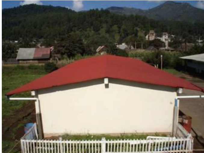
Figura 3. Techo casa convencional de un piso utilizada para captador de aguas lluvias
