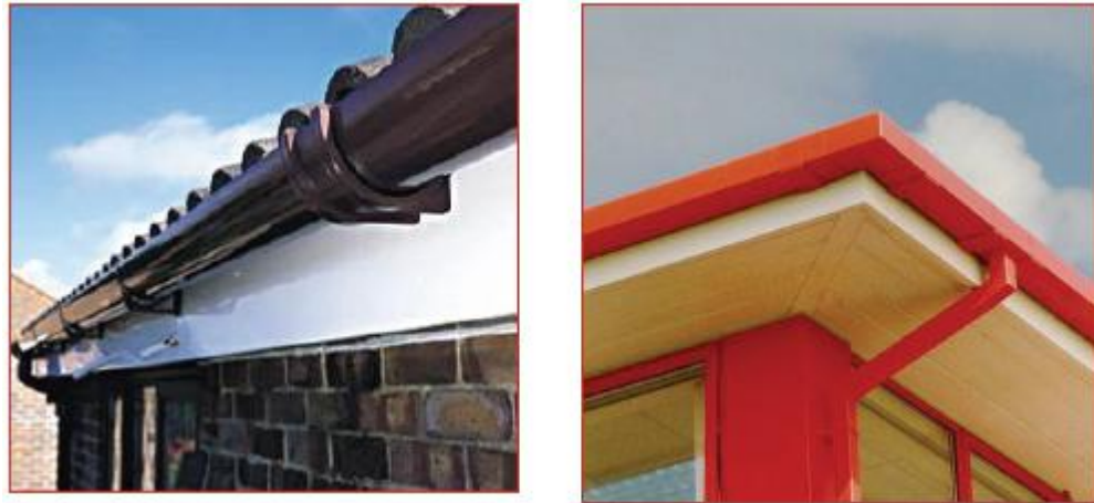
Figura 4. Canales de recolección de aguas lluvias en casas convencionales
