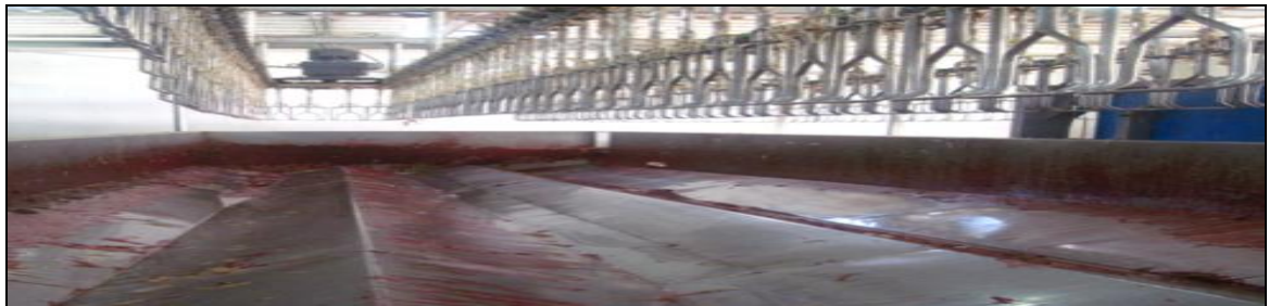
FOTO 2. Canal de desangre.
