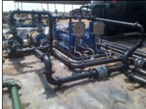
Figura 75. Bombas de transferencia conectadas mecánicamente con tubería tipo unión de golpe.
