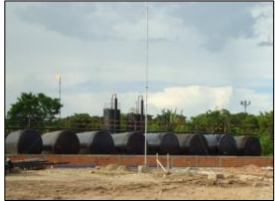
Figura 11. Fotografía construcción diques en bloque y mampostería.
