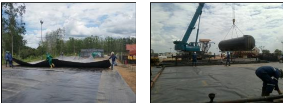
Figura 10. Fotografía instalación geo-membrana
