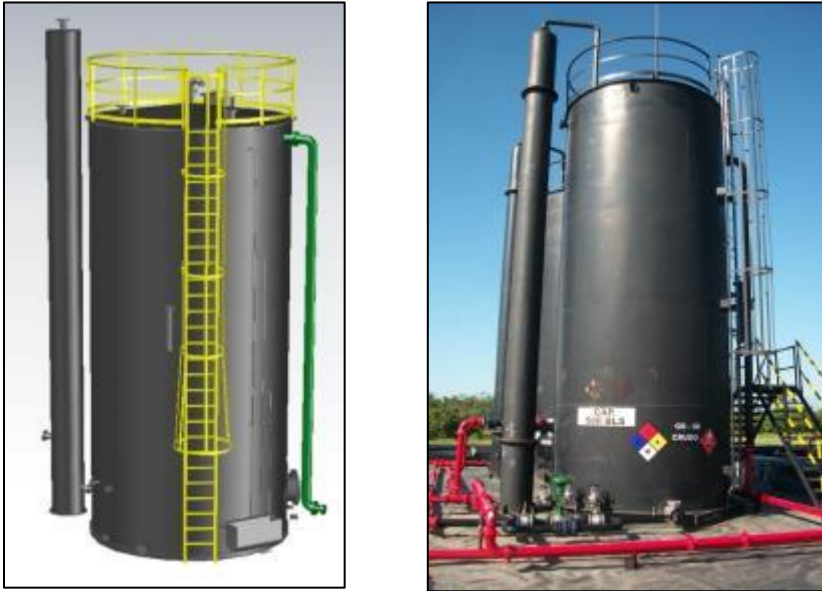
Figura 37. Gun Barrel y Bota de Gas convencionales
