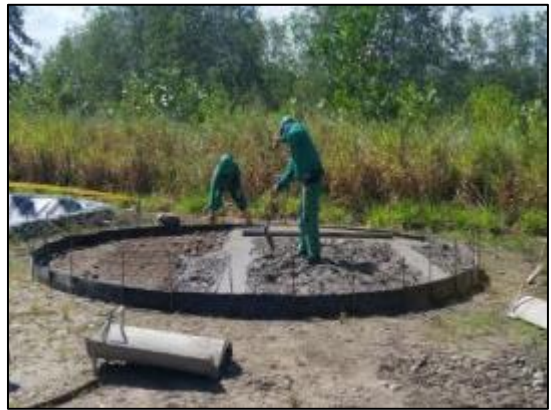
Figura 15. Fotografías construcción de placas en concreto para equipos de well Testing
