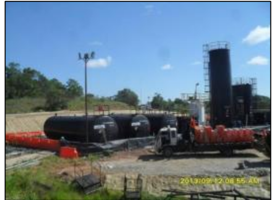
Figura 13. Fotografías construcción de diques en maletines plásticos de señalización vial
