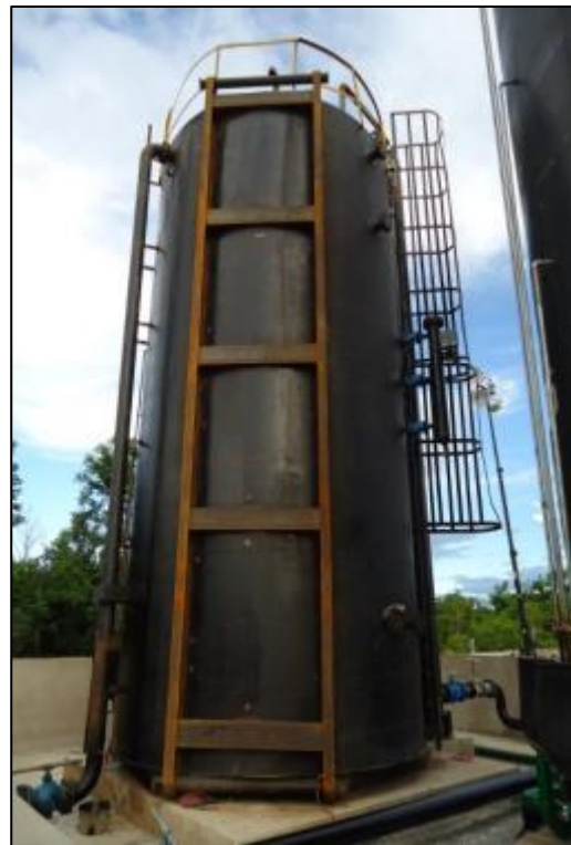
Figura 50. Fotografía y diagrama de un Gun Barrel con Skid en base y para ser transportado adecuadamente
