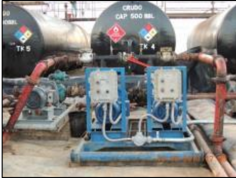
Figura 75. Bombas de transferencia conectadas mecánicamente con tubería tipo unión de golpe.
