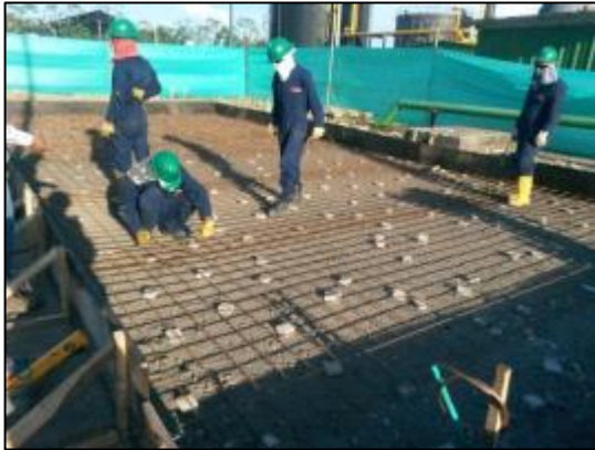
Figura 9. Fotografía construcción malla a Tierra
