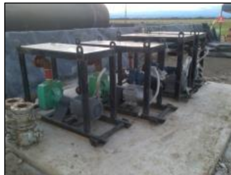
Figura 74. Bombas de transferencia para cargue de crudo y agua independientes
