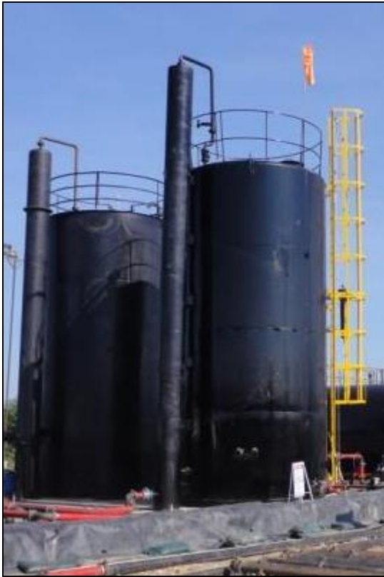
Figura 55. Fotografía Gun Barrel de 500 Bls con Bota de gas integral y bota de gas seccionada. Vista superior difusor
