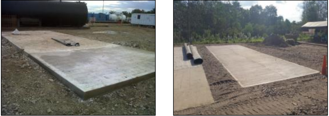
Figura 16. Fotografías placas en concreto en periodo de fragüe
