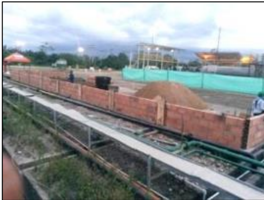
Figura 11. Fotografía construcción diques en bloque y mampostería.
