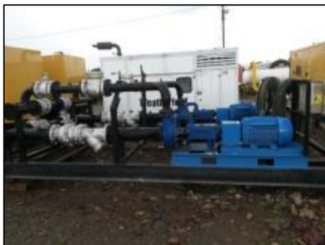
Figura 76. Skid de dos Bombas centrífugas con colectores de succión y descarga
