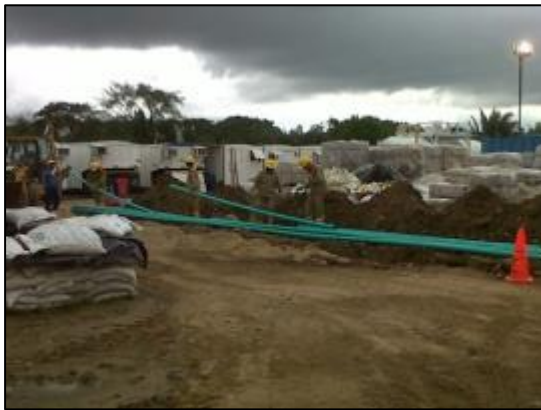
Figura 19. Fotografía construcción banco de ductos
