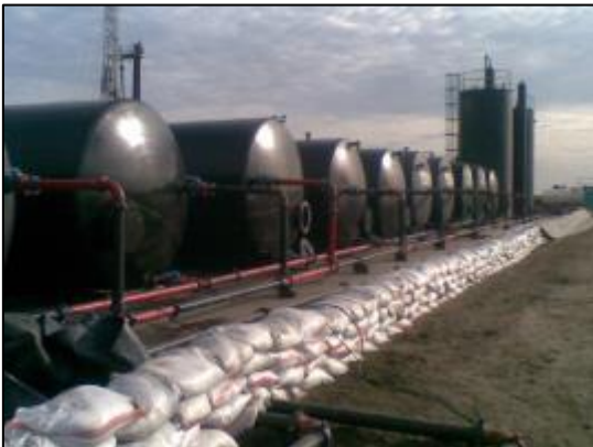
Figura 12. Fotografía construcción de diques con saco-suelos
