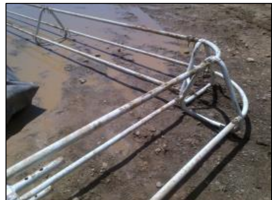
Figura 14. Fotografías construcción de diques metálicos en tubería
