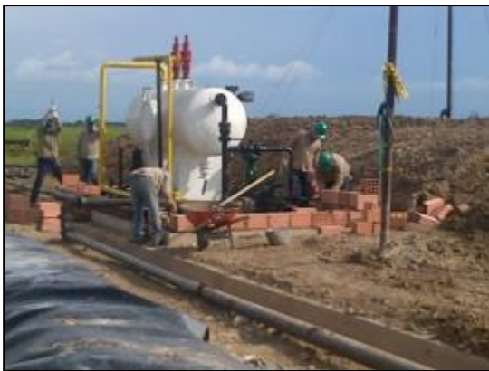
Figura 17. Fotografía construcción de placas en concreto para equipos del Set de gas (separador, scrubber, ko-drum y TEA)
