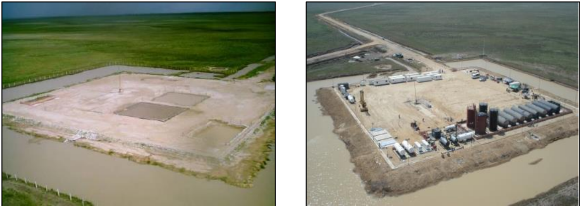
Figura 6. Fotografía antes y después del Rig-up del equipo de superficie para pruebas iniciales de producción de un Pozo exploratorio.
