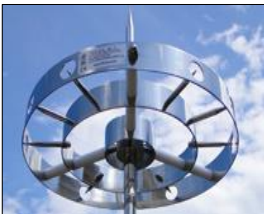
Figura 42. Equipo de apantallamiento contra descargas atmosféricas tipo ionizante
