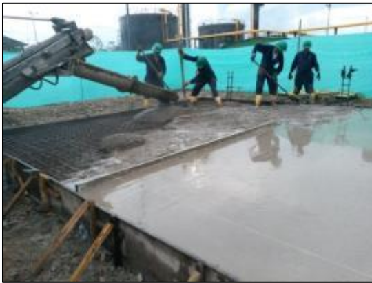
Figura 15. Fotografías construcción de placas en concreto para equipos de well Testing
