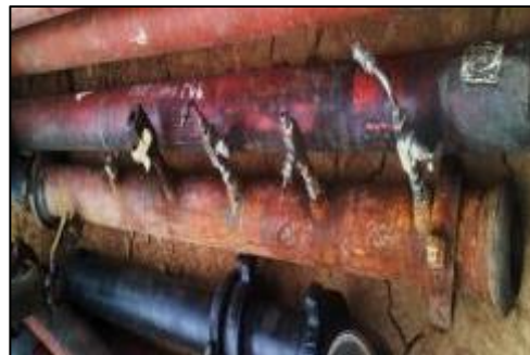
Figura 28. Data header en tubería roscada tipo unión de golpe
