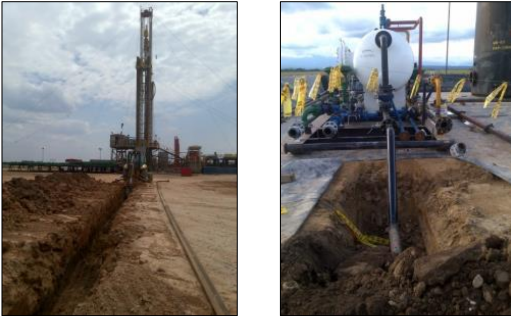
Figura 18. Fotografías excavación para enterrar línea de producción
