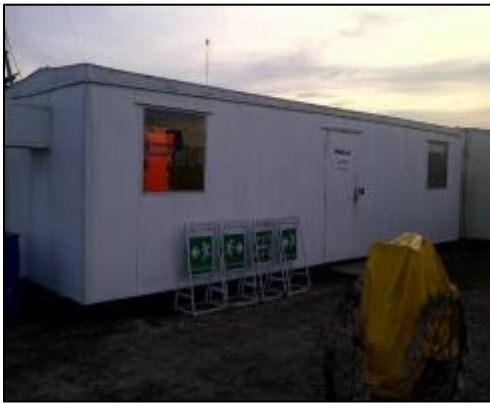
Figura 46. Caseta oficina-comedor convencional
