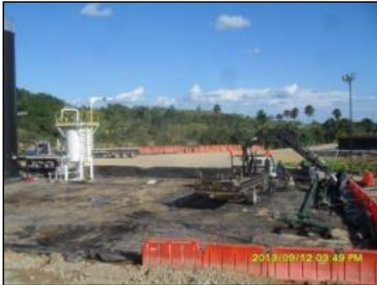
Figura 13. Fotografías construcción de diques en maletines plásticos de señalización vial
