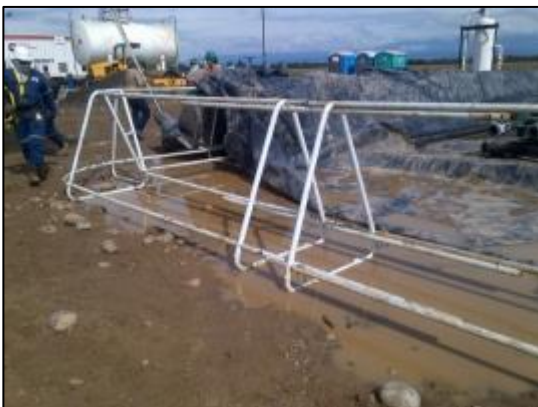
Figura 14. Fotografías construcción de diques metálicos en tubería
