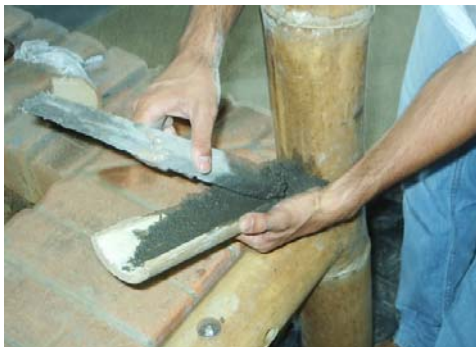
Fotografía 38. Inyección de mortero
