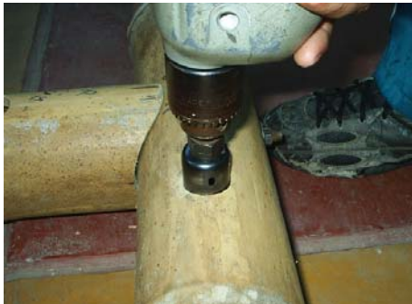
Fotografía 38. Inyección de mortero
