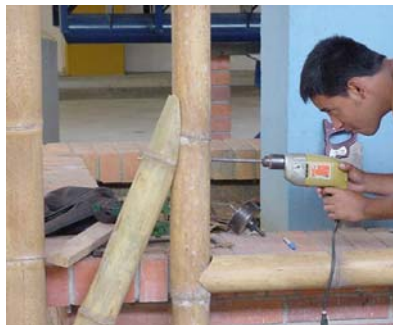
Fotografía 31. Perforando para los pernos
