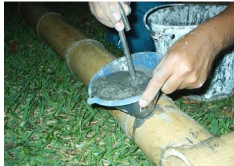
Fotografía 39. Mortero en las soleras
