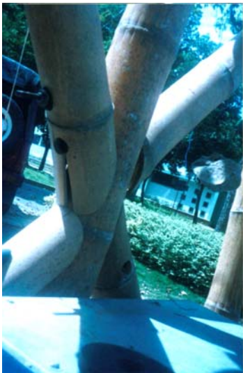
Fotografía 51. Punto 5 panel muro
