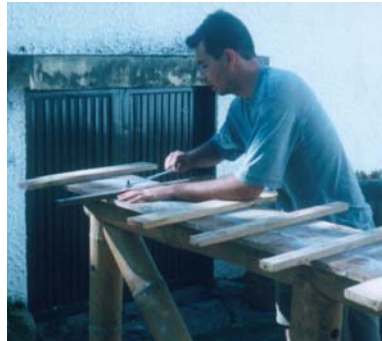
Fotografía 42. Tablón con elementos transversales
