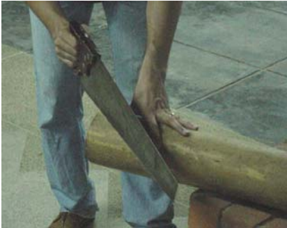
Fotografía 28. Corte de picoeflauta
