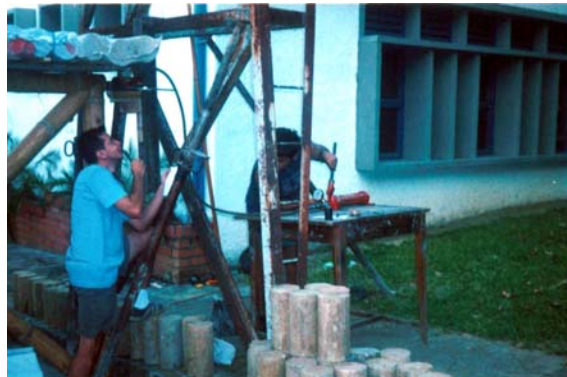
Fotografía 47. Aplicación de carga
