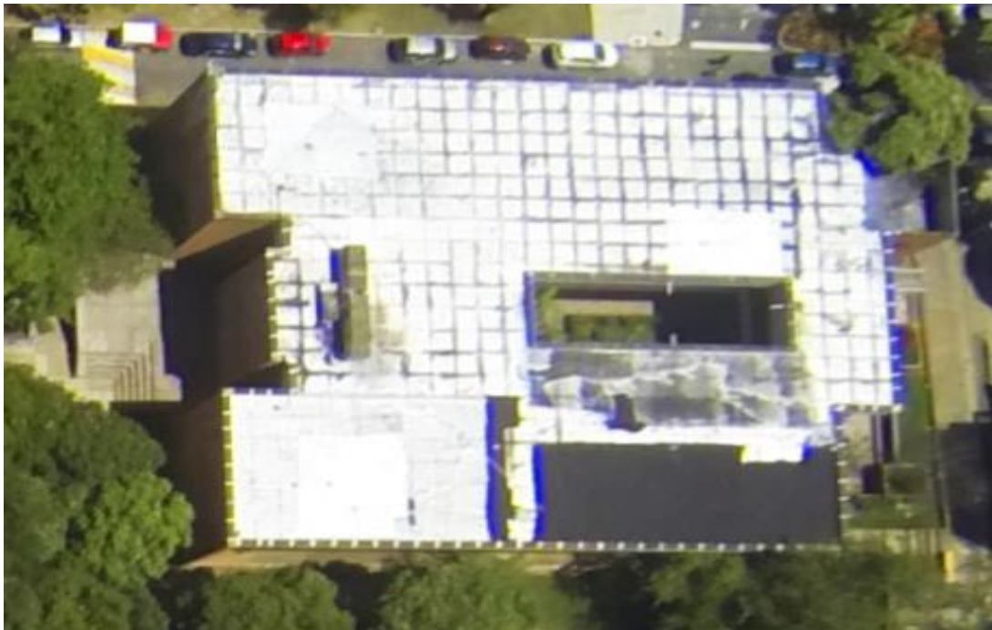
Figura 8. Cubierta en concreto del Mamitza Bayer
