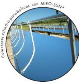
Instalación de colectores cilindro-parabólicos con MIRO-SUN*
