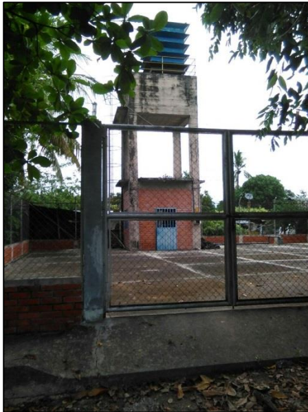
Pozo subterráneo central (90 mts)
