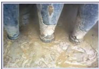
Figura 32. Control de Limpieza.
