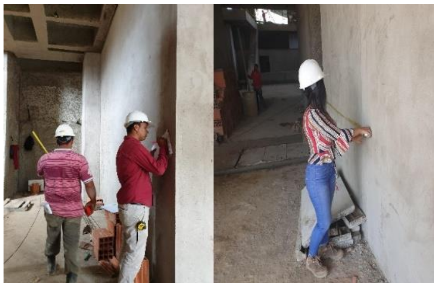
Figura 7. Supervisión de cantidades ejecutadas en obra.
