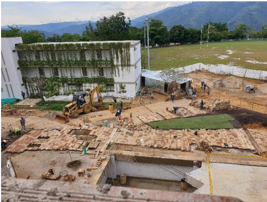
Figura 8. Avance de instalación piedra Barichara en Plazoleta Aledaña.
