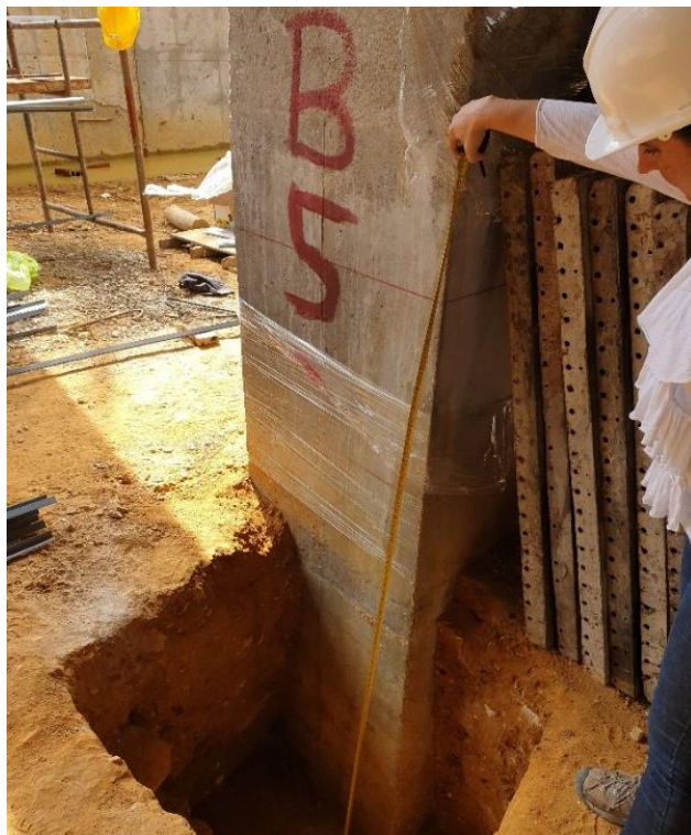
Figura 5. Revisión de niveles placa de contrapiso.
