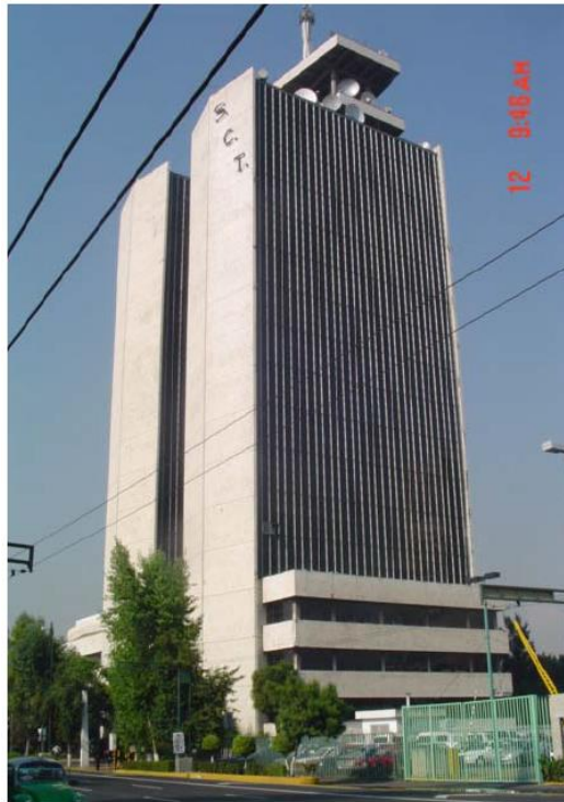
Figura 19. Vista del edificio Telecomm 68 .
