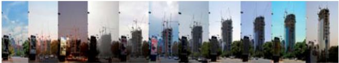
Figura 13. Secuencia constructiva Titanium la portada.
