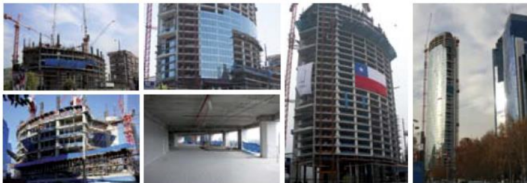
Figura 12. Titanium la portada. Proceso constructivo.
