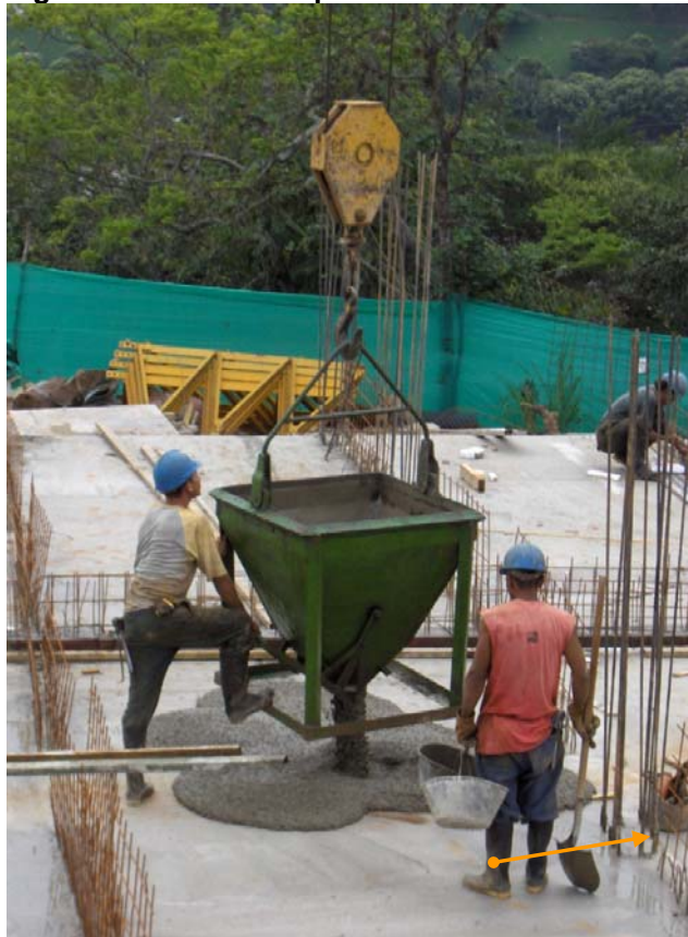
Figura 34. Concreto para fundida de dados
