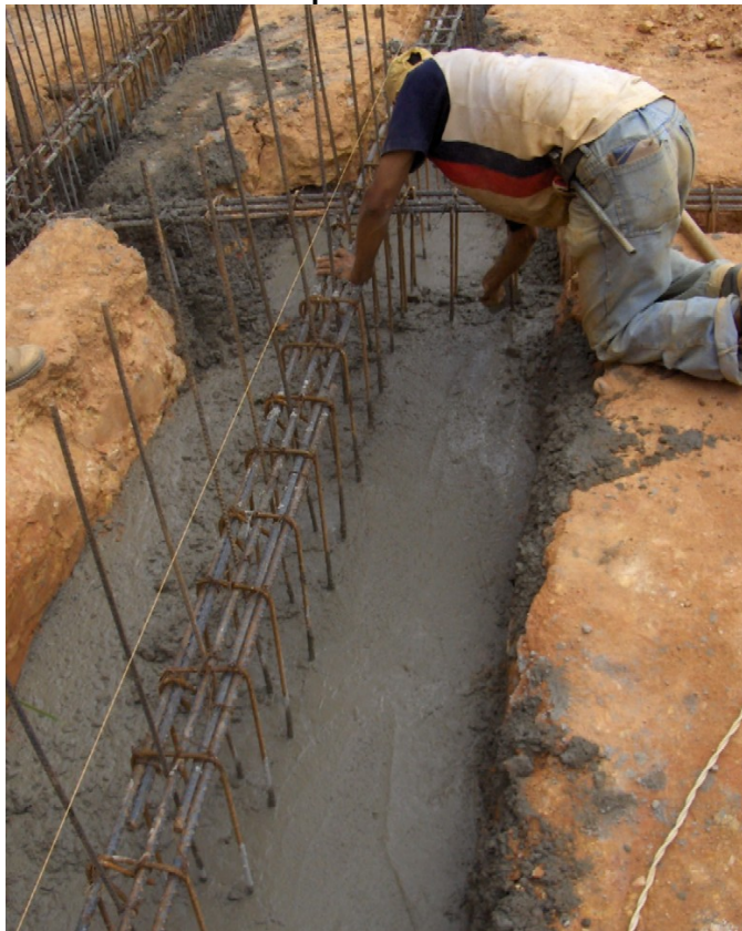
Figura 14. Allanando la zarpa de la cimentación de la torre 7
