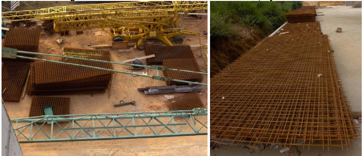
Figura 16. Mallas electrosoldadas de las torres 1, 2 y 6
