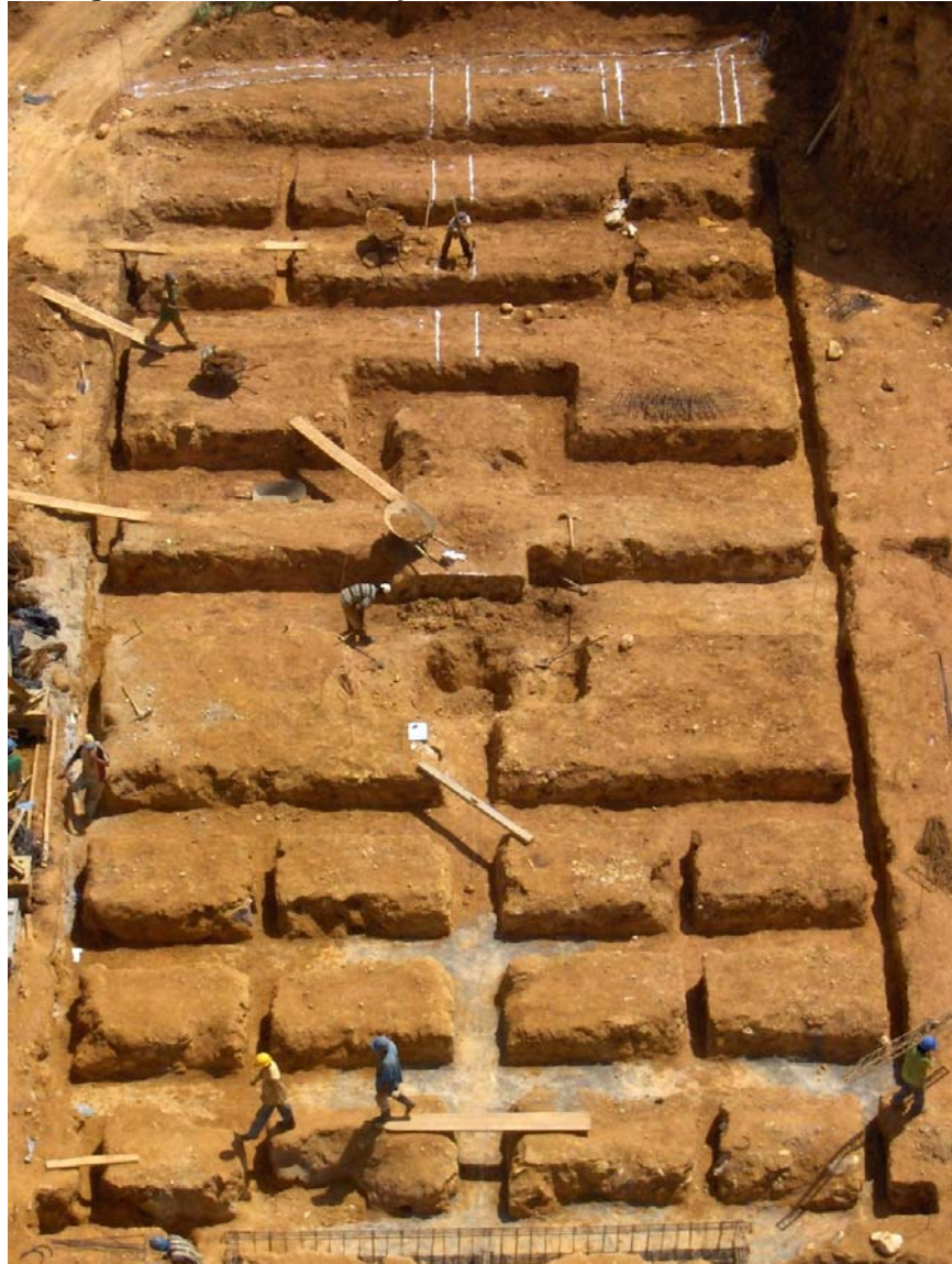
Figura 8. Excavación para la cimentación de la torre 8
