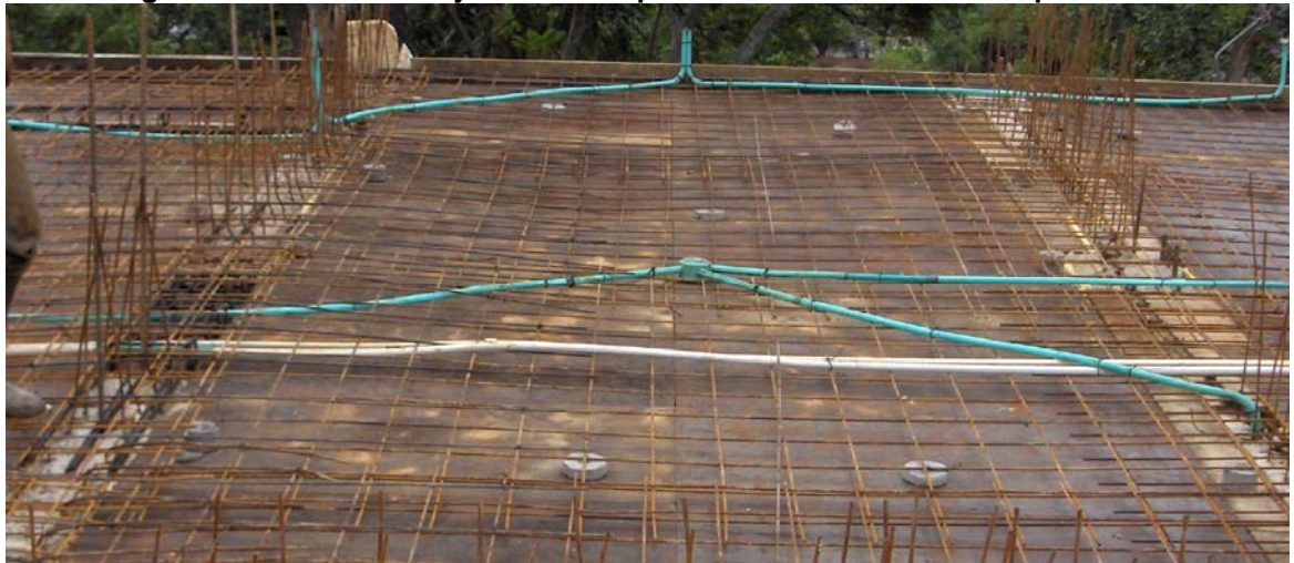
Figura 18. Curvatura fijada en obra para la malla de refuerzo de placa
