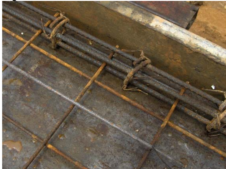
Figura 20. Malla entre refuerzo adicional de borde
