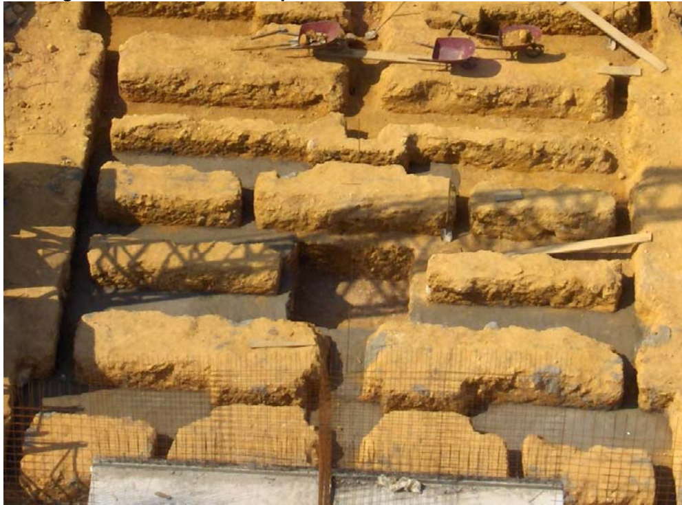
Figura 10. Mortero de limpieza de la cimentación de la Torre 1
