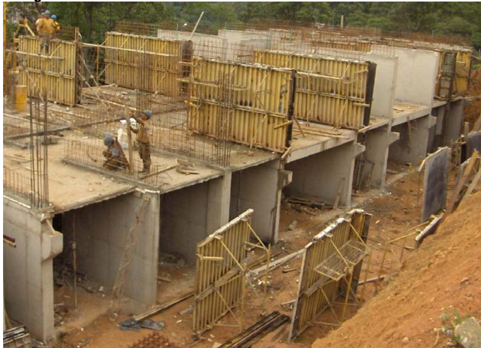
Figura 43. Formaleta Outinord en muros de sótano de Torre 8
