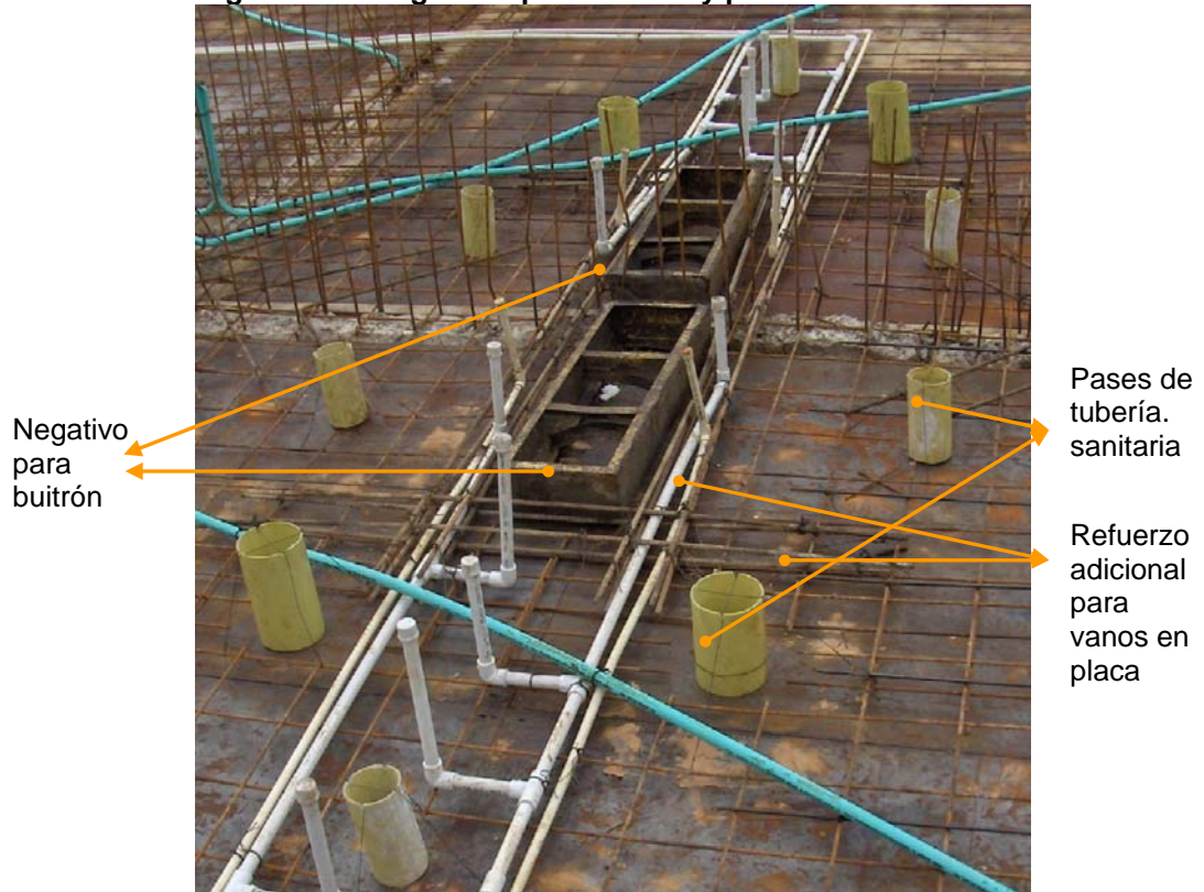
Figura 29. Negativos para buitrón y pases de tubería
