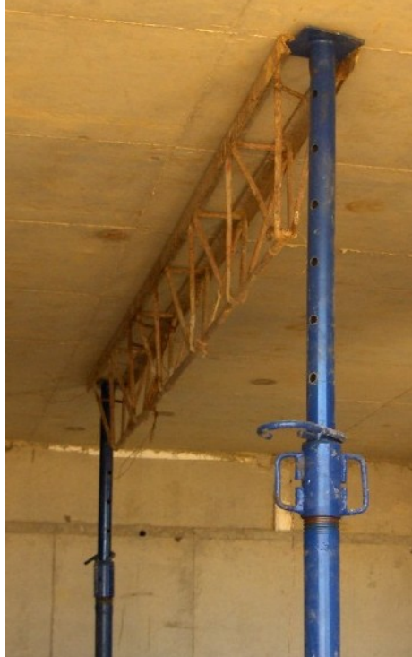
Figura 31. Soporte temporal de placas con parales y cerchas
