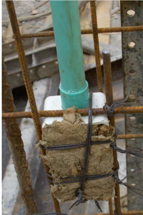
Figura 28. Caja eléctrica lista para la fundida
