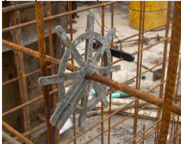
Figura 39. Separador plástico sencillo para muros de 12 cm de espesor
