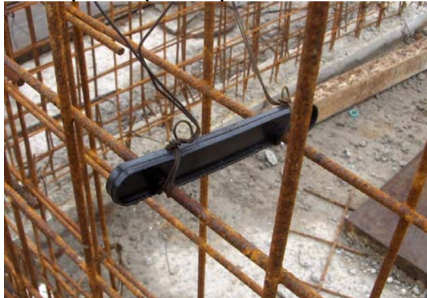
Figura 40. Separador plástico para muros de doble malla
