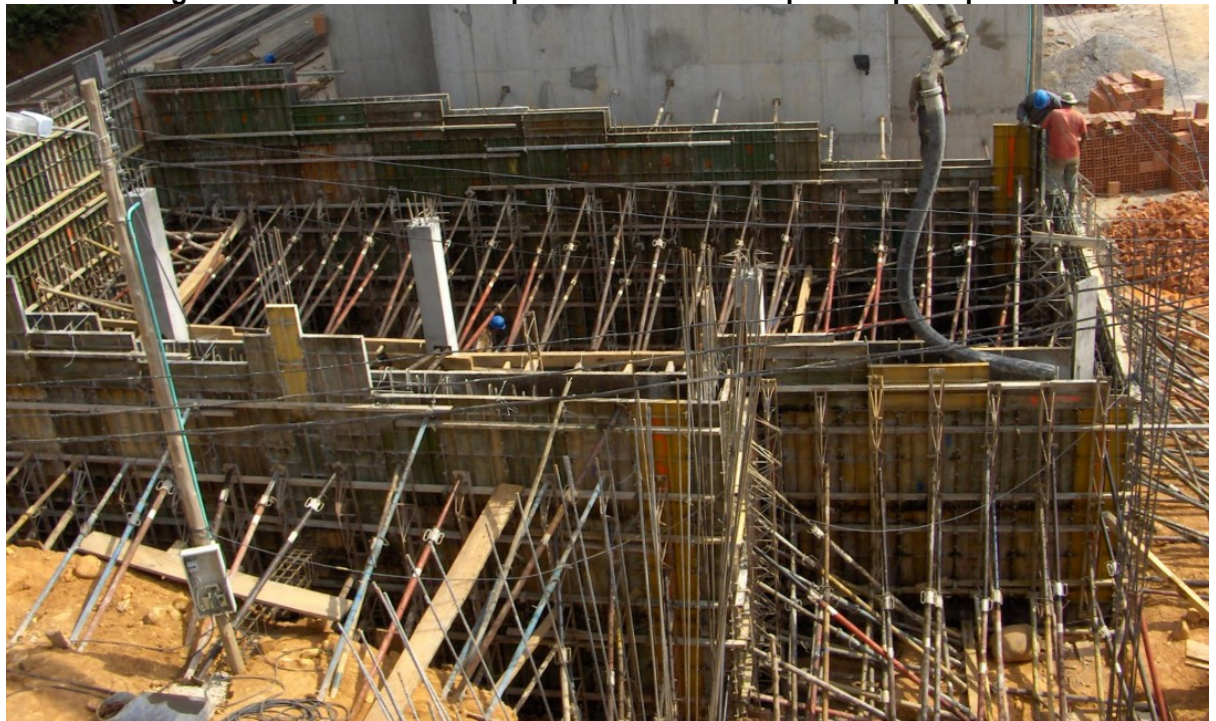
Figura 48. Fundida del tanque subterráneo de la portería principal
