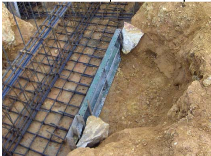
Figura 60. Formaleta colocada para reducir el desperdicio
