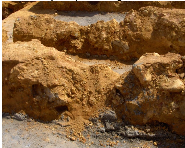
Figura 59. Vacíos por extracción de rocas encontradas en las paredes del suelo y por el paso de la gente
