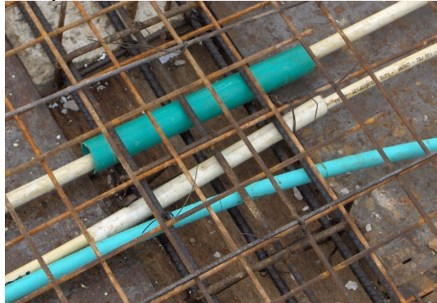
Figura 27. Pases para tubería hidráulica a través de muros de concreto
