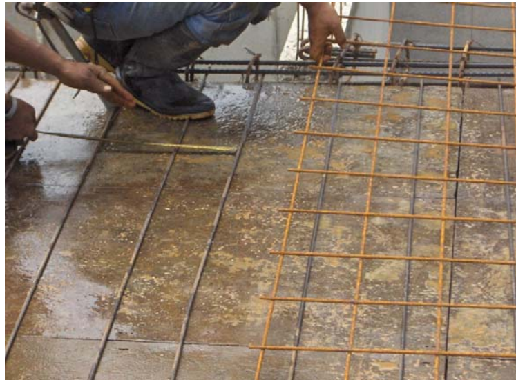
Figura 22. Colocando la malla sobre el refuerzo adicional inferior
