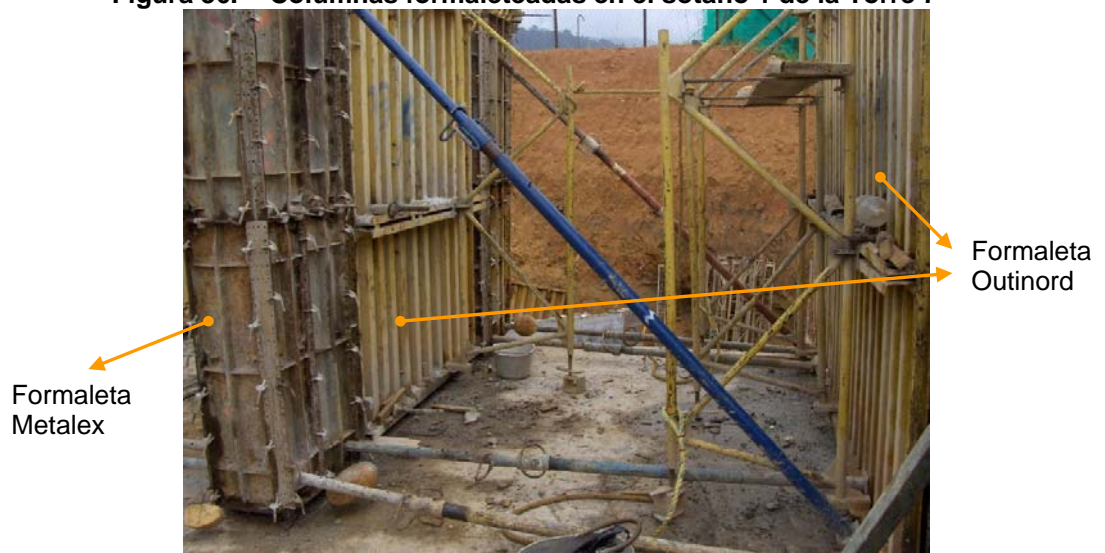
Figura 36. Columnas formaleteadas en el sótano 1 de la Torre 7
