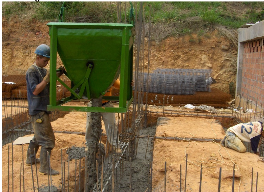
Figura 13. Vaciado de la cimentación de la torre 7
