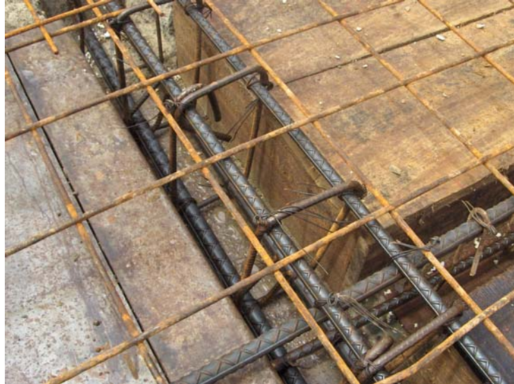
Figura 19. Malla colocada sobre el refuerzo de la viga descolgada
