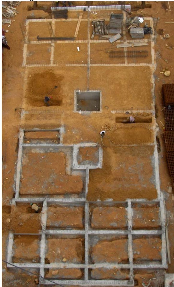
Figura 15. Cimentación de la torre 7
