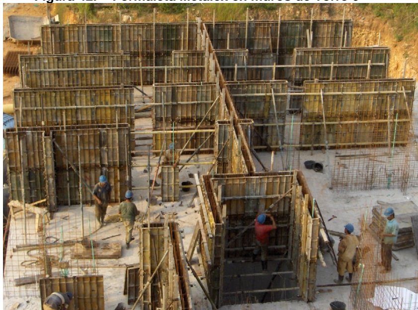
Figura 42. Formaleta Metalex en muros de Torre 6
