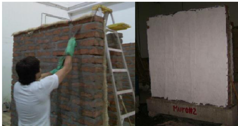
Figura 32. Aplicación del refuerzo y pintado de muros.
