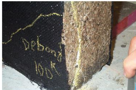
Figura 3 . Falla de un muro reforzado con FRP (MOSALLAM & SWAGATA, 2011)
