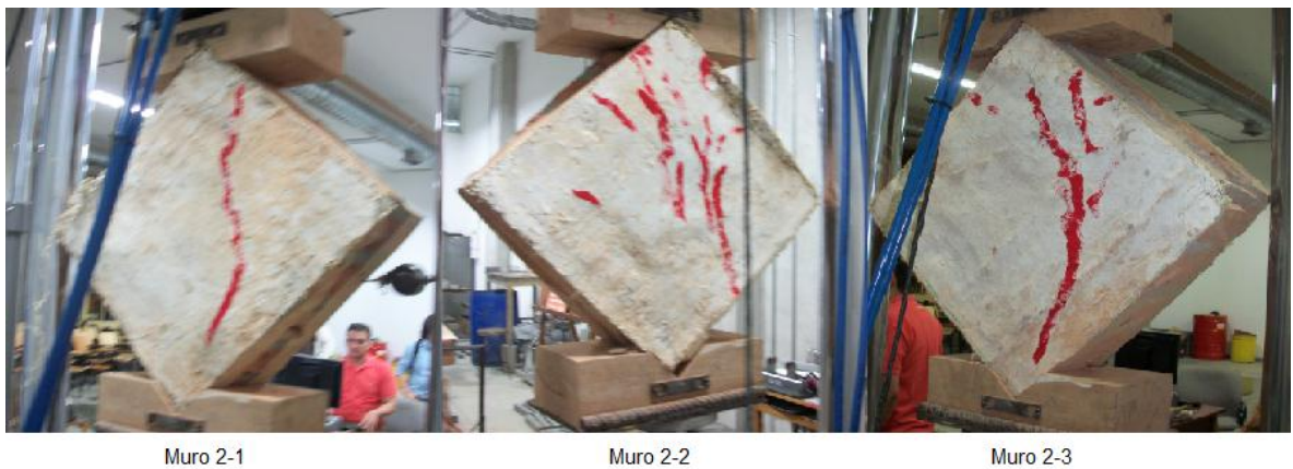
Figura 56. Fallas muretes tipo 2 Fuente los Autores
