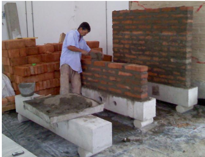
Figura 31. Proceso de construcción de muros.
