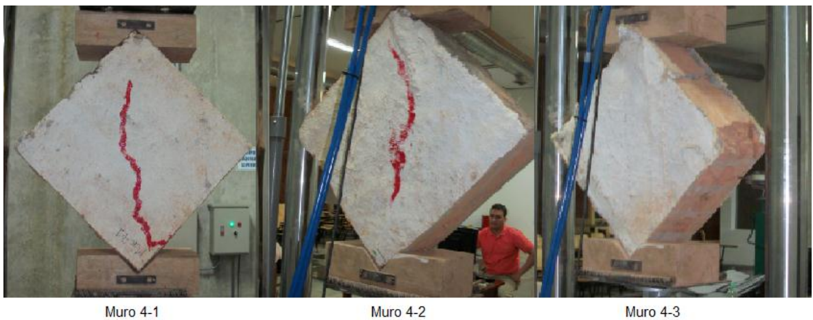
Figura 64. Fallas muretes tipo 4 Fuente los Autores
