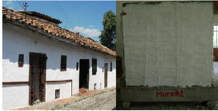
Muro Frisado - Rustico
