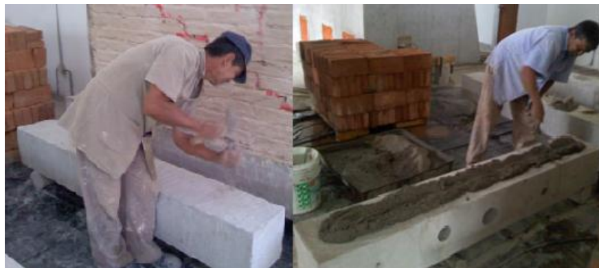
Figura 30. Primera hilada de mortero
