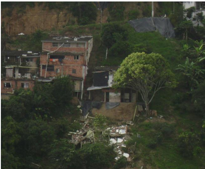
Figura 10. Vivienda después del colapso, comuna 14 "Morrónico" Fuentes los Autores
