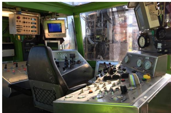
Figura 14. Centro de control de un taladro hidráulico
