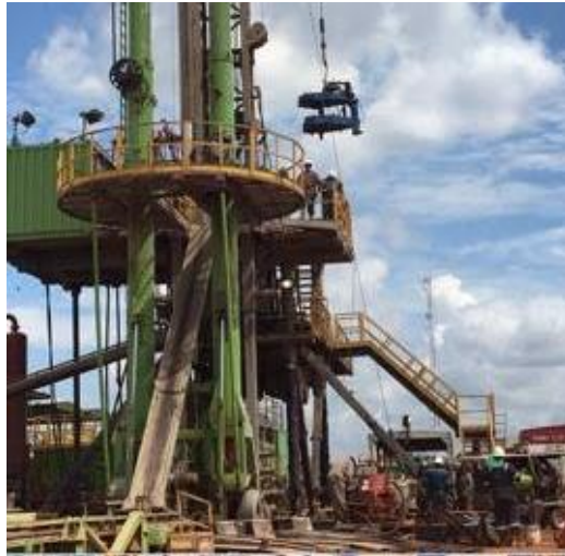
Figura 18. Rampa para tubería de un taladro hidráulico
