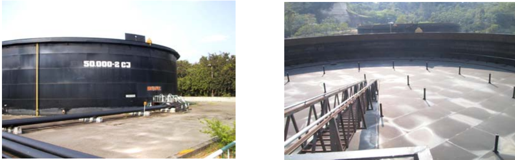
Figura 1.9 - Tanques de Techo Flotante Estación de Bombeo Teca (EBT)
