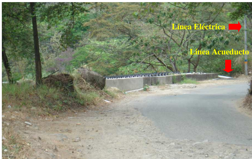
Fotografía 7. Congestión de la vía margen izquierdo, debido a obras de protección, redes eléctricas y el acueducto del Municipio.
