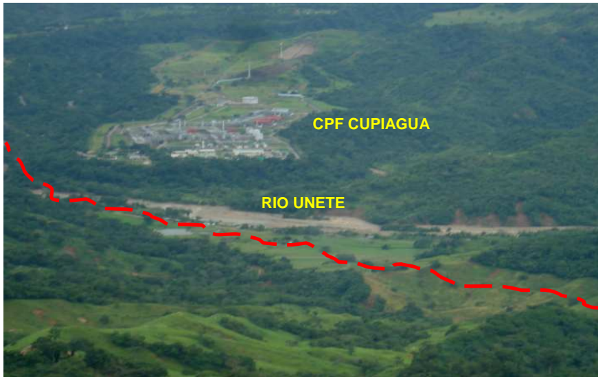
Fotografía 12. Paso sobre el rio Unete del nuevo trazado.
