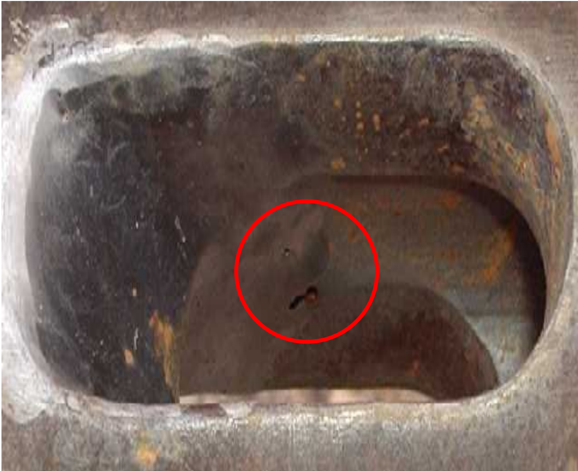
Figura 32. Wash out (erosión) en herramienta empaquetadora de grava.
