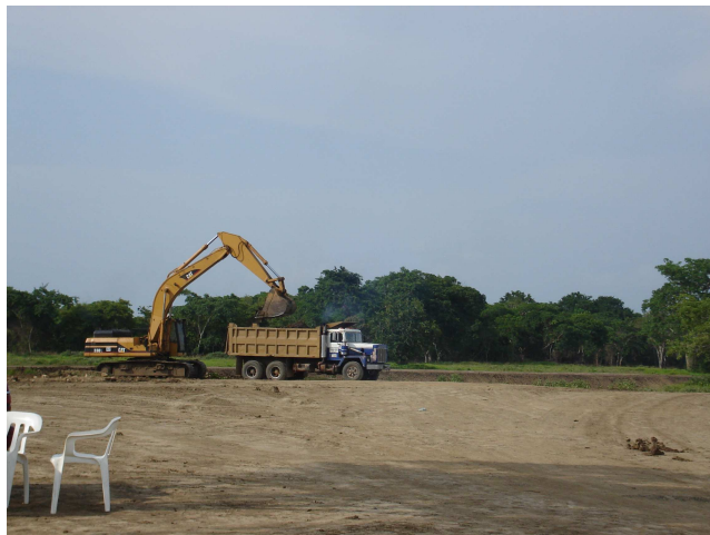
Figura 6. Excavación de Caja
