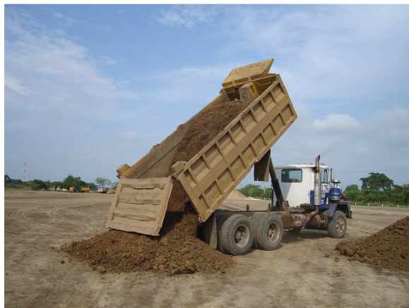
Figura 9. Volqueta descargando material
