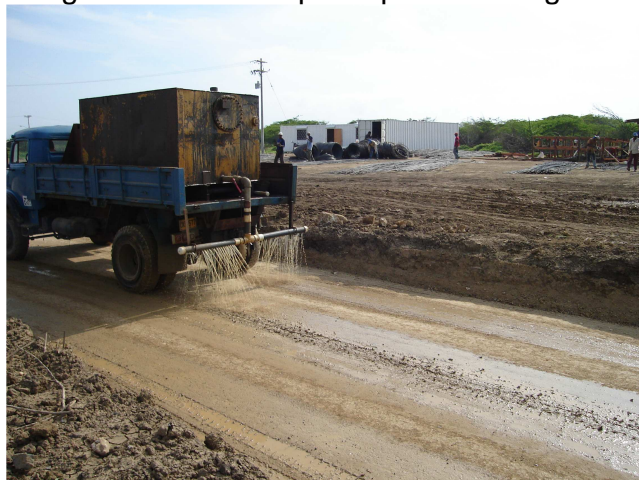
Figura 8. Carrotanque esparciendo agua
