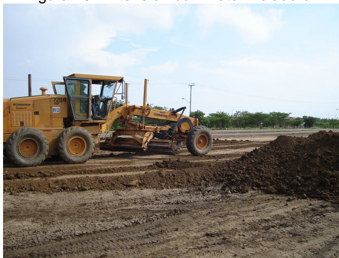
Figura 10. Extensión con motoniveladora
