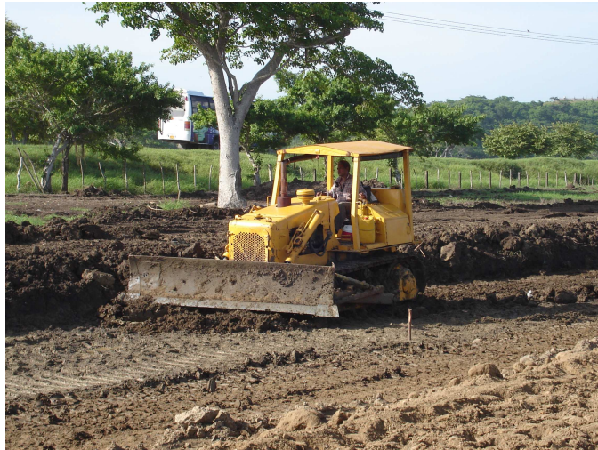
Figura 7. Descapote subrazante
