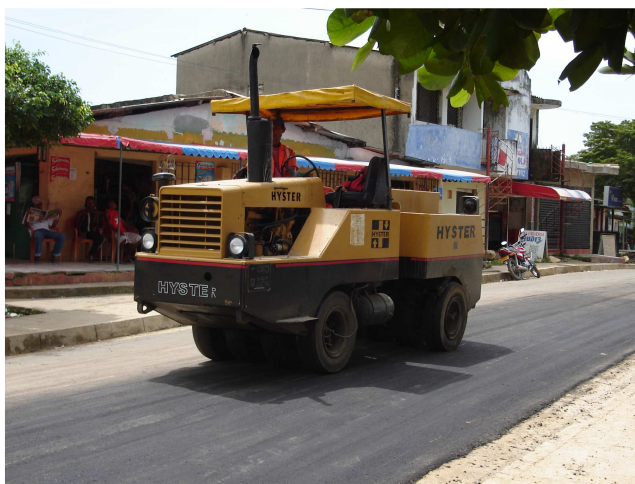
Figura 13. Acabado final de la vía
