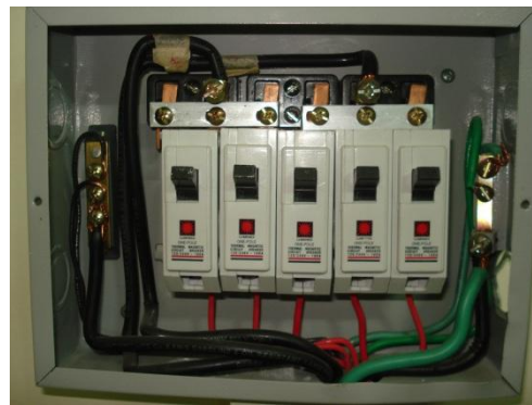
Figura 19. Barraje Tablero TE
