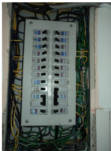
Figura 16. Barraje del Tablero TJ
