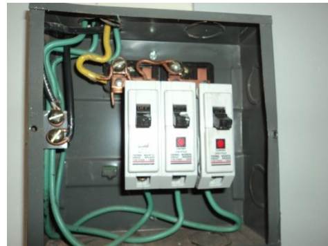
Figura 18. Barraje del Tablero TL
