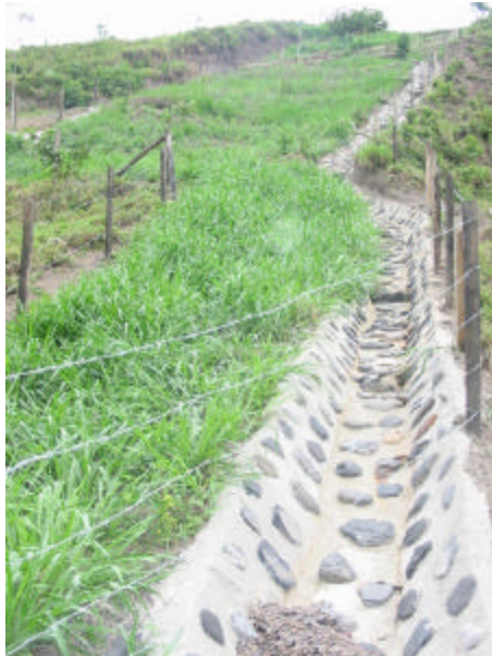
Ilustración 4 Canal Lateral en Piedra Pegada
