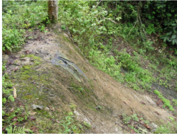
Ilustración 9 Cobertura en Concreto y Malla
