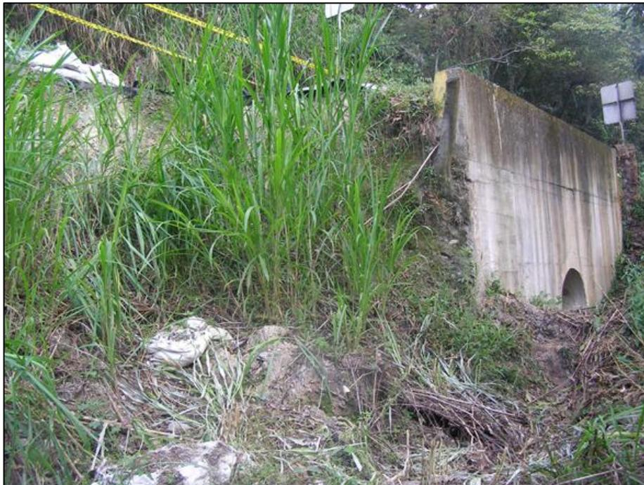
Ilustración 3: Vista del descole de una alcantarilla localizada en uno de los costados del fallo, no se observaron grietas en el muro.
