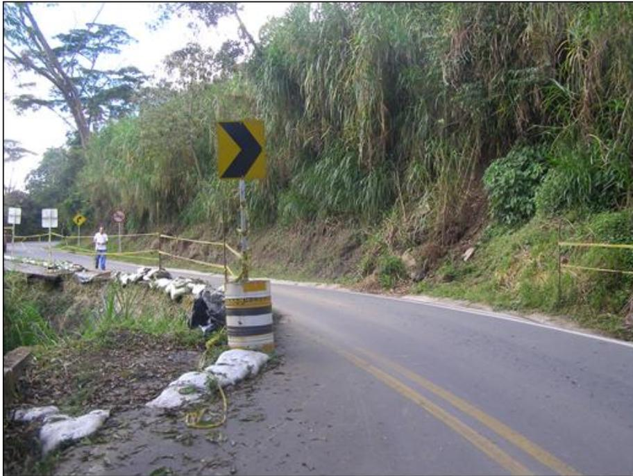
Ilustración 2: Vista general del deslizamiento, se observa el desplazamiento de la mitad de la banca de la vía.
