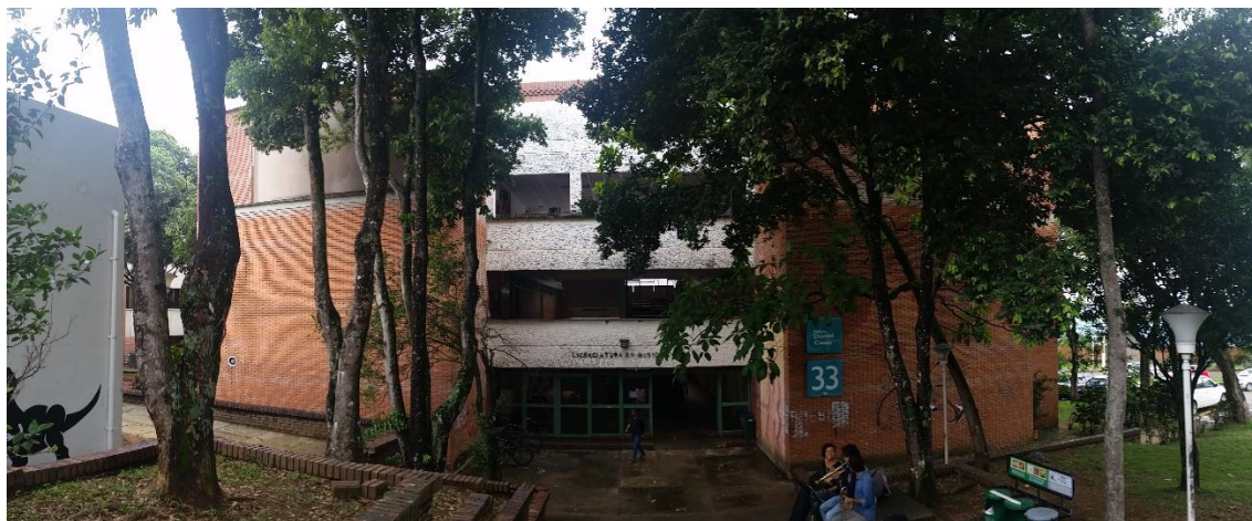
Figura 45. Fachada del edificio Daniel Casas
