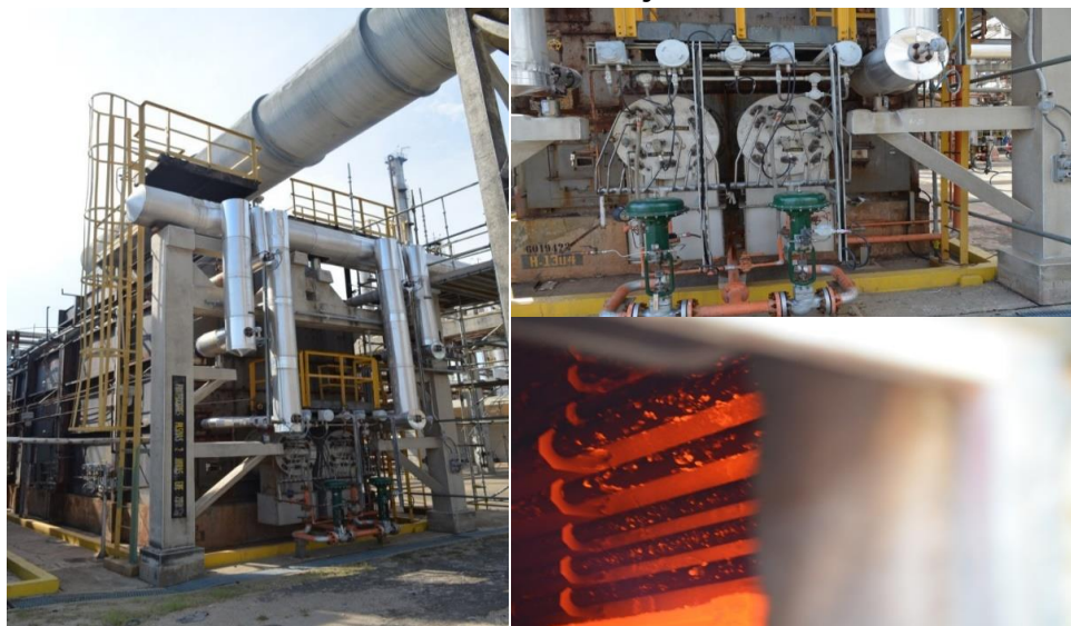
Figura 146. Estudio de la corrosión del acero ASTM A335 P5 en un horno de aromáticos de la refinería de Barrancabermeja
