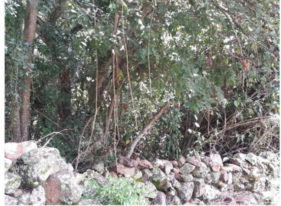
Foto 2. Afloramiento delimitado con cimiento en piedra
