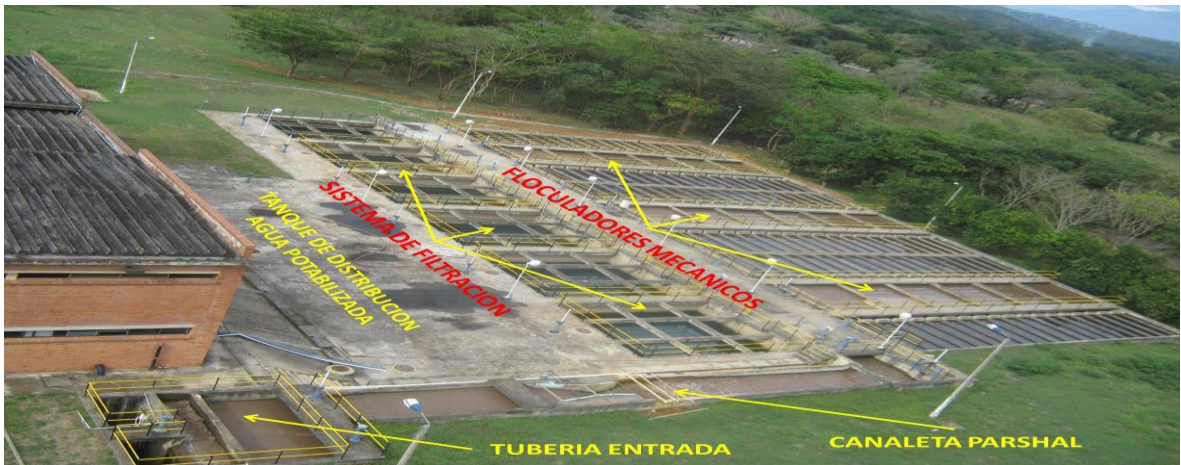
Figura 6. Esquema Sistema de Producción Planta de Carmen de Tonchalá
