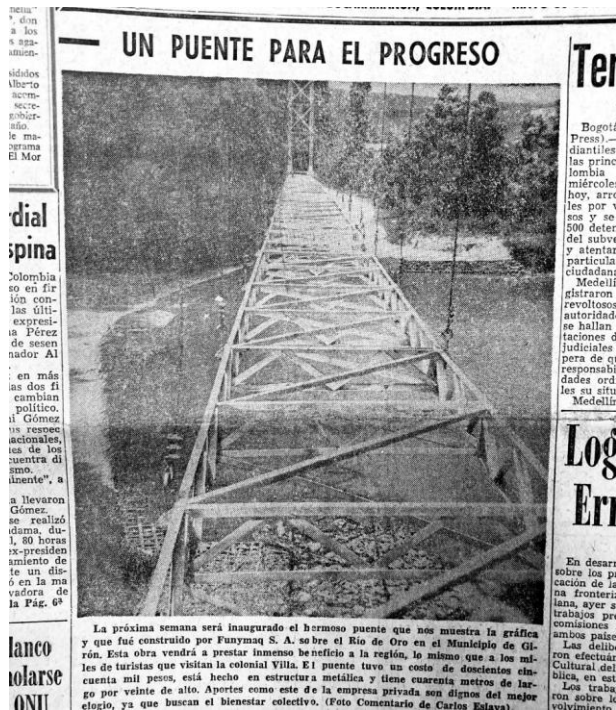
Figura 10. Fotografía “Un puente para el progreso”. Vanguardia Liberal, sección “Fotógrafo Fisgón” 30 de mayo de 1969, p. 1.
