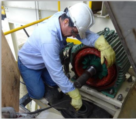
Figura. 23. Cambio Rodamiento en Extractor y Cambio de Eje de Turbina
