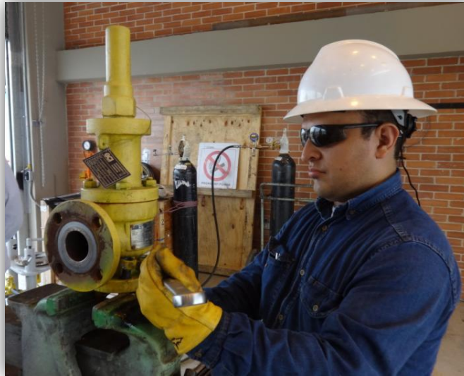
Figura. 24. Mantenimiento y Calibración de Válvulas de Seguridad
