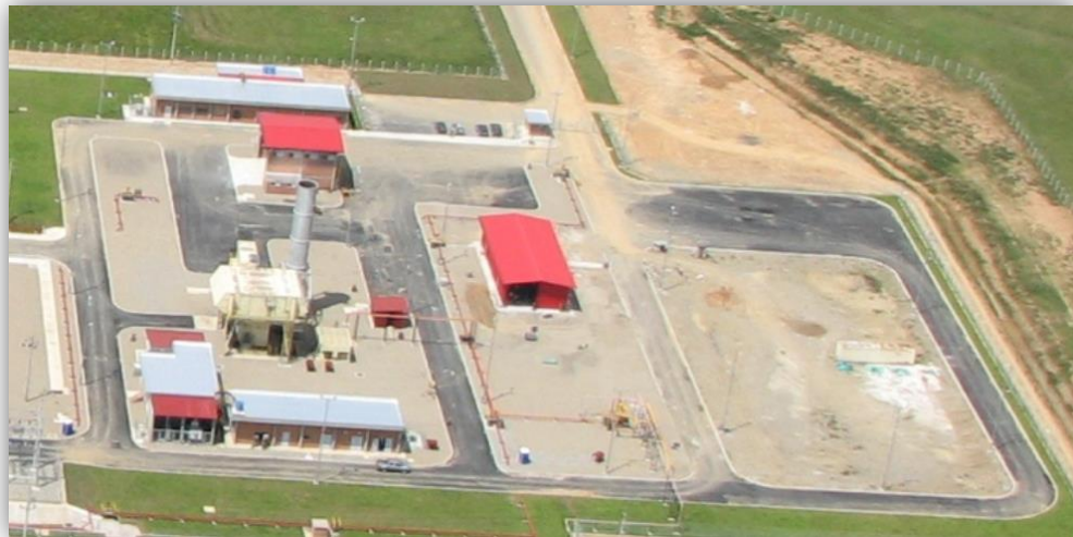
Figura. 8 Vista Aérea de Termosuria GDA-ECP.
