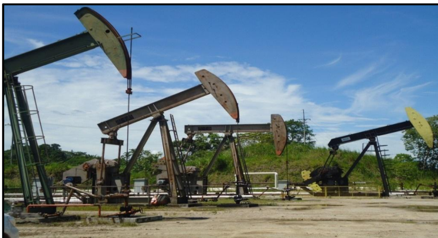
Figura 3. Pozos de un Cluster en Campo Jazmín.
