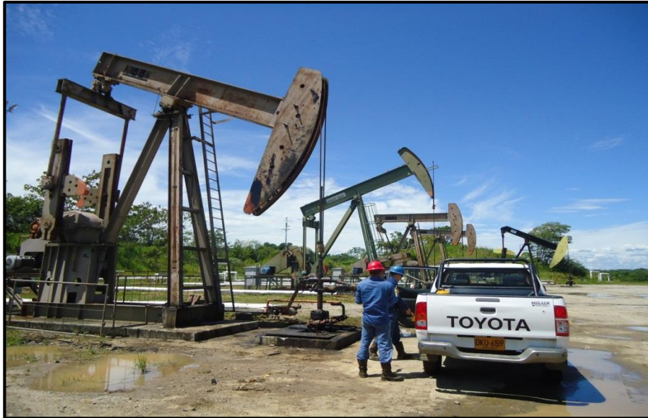
Figura 5. Unidad de Bombeo Mecánico en Campo Jazmín.
