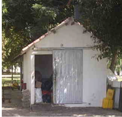
Centro de acopio Fuente: Autores
