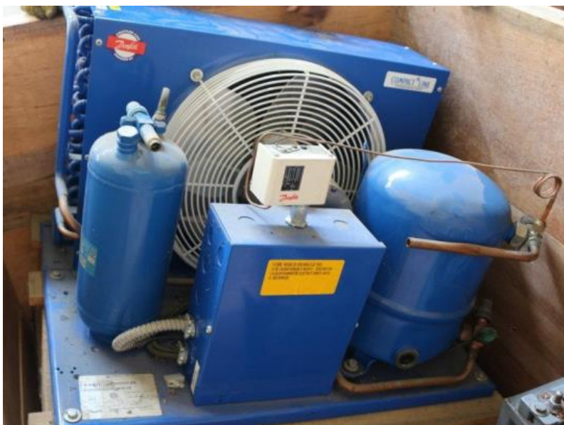
Figura 11. Unidad condensadora Danfoss LCZ028E20Q
