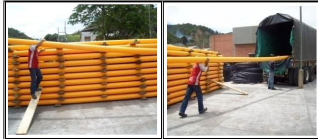
Figura 62. Cargue manual de tubería
