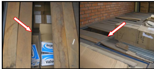
Figura 10. Módulos de estantería en malas condiciones
