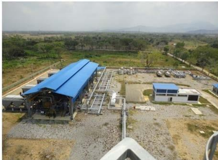
Fotografía 4. Estación Compresora Curumaní
