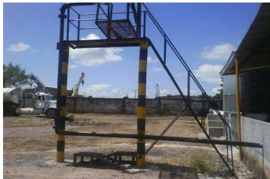
Figura 6. Zona de descarga de asfalto
