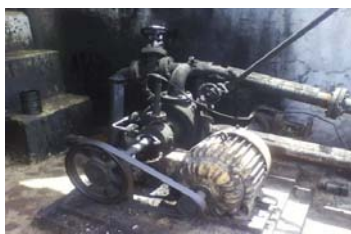
Figura 15. Cargue de la emulsión asfáltica
