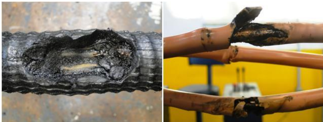
Figura 18. Falla eléctrica por afectación mecánica del cable.
