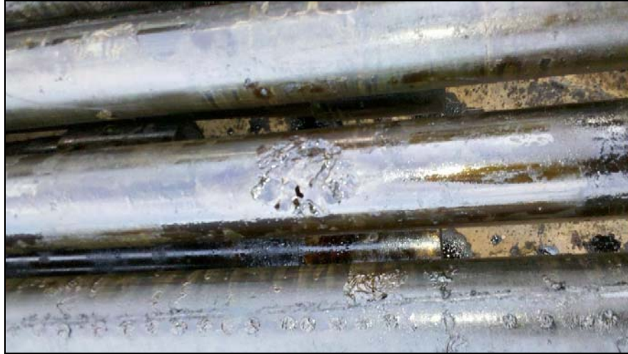
Figura 20 Tubería Jeteada CBE 1060
