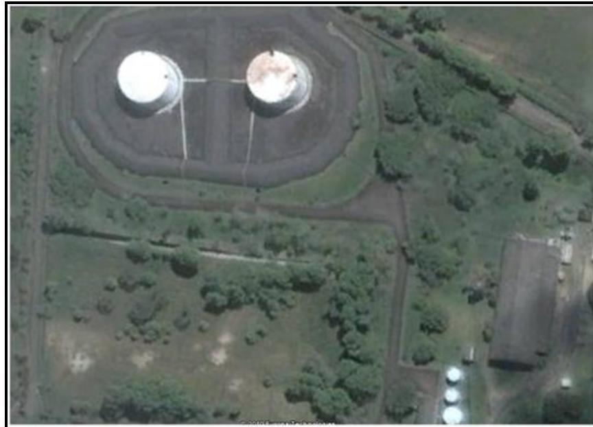
Figura 15 Estación de bombeo cóndor
