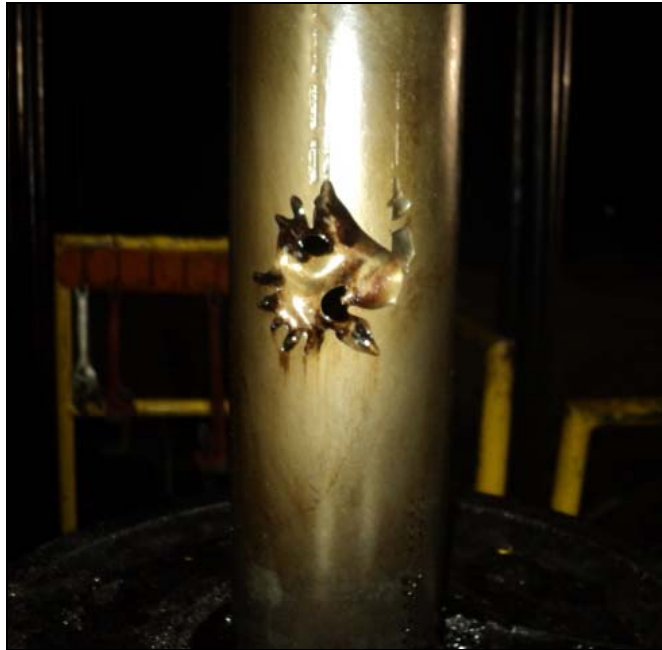
Figura 18 Tubería Jeteada CBE 1091
