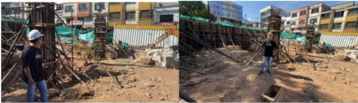
Figura 7. Acompañamiento de primer visita visita a obra Remodelación del Parque Principal de San Vicente de Chucurí
