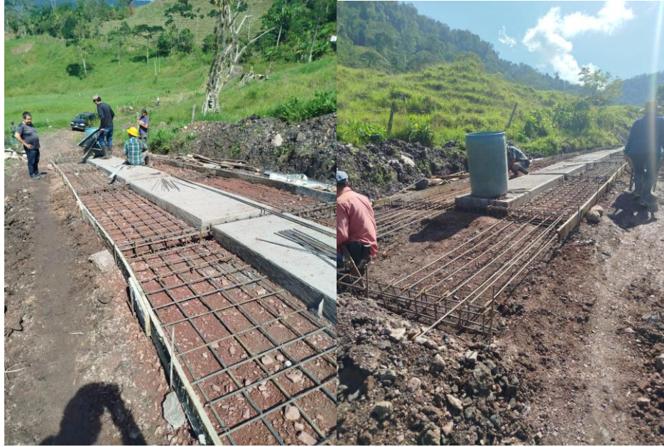
Figura 10. Visita a obra de Construcción de Placa Huellas Vereda Pamplonita
