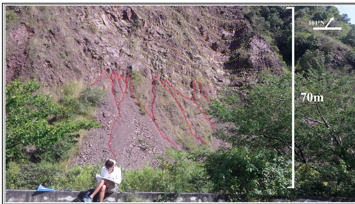
Figura 34. Conos de talús (líneas rojas) paralelos al cauce del Río Suratá resultantes de la caída de bloques en el costado norte de la zona, justo por debajo de la secuencia de la Formación Jordán (líneas punteadas amarillas).
